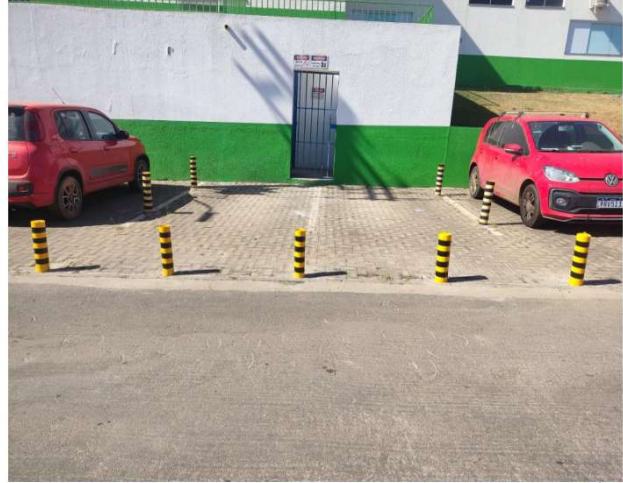
ESTACIONAMENTO EXTERNO – INSTALAÇÃO DE POSTES PARA BLOQUEIO DE VAGAS PRÓXIMO EM FRENTE AO ABRIGO GLP
