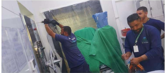
CME - INSTALAÇÃO DE CHAPA INOX PARA VEDAÇÃO DE VÃO DA AUTOCLAVE
