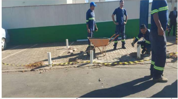
ESTACIONAMENTO EXTERNO – INSTALAÇÃO DE POSTES PARA BLOQUEIO DE VAGAS PRÓXIMO AO PORTÃO DE ACESSO DE CARGAS/DESCARGAS
