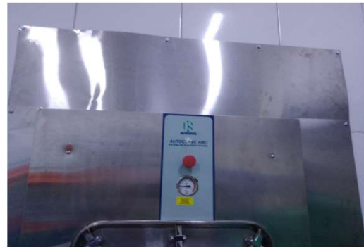
CME - INSTALAÇÃO DE CHAPA INOX PARA VEDAÇÃO DE VÃO DA AUTOCLAVE
