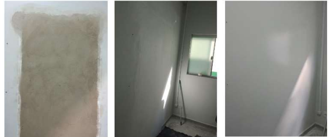
SESMT – ISOLAMENTO DE VÃO DE PORTA PARA DIVISÃO DE AMBIENTES (SESMT/REPOUSO)
