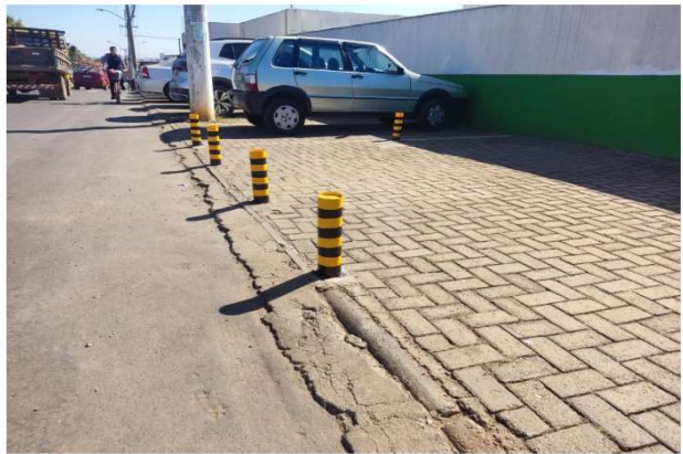
ESTACIONAMENTO EXTERNO – INSTALAÇÃO DE POSTES PARA BLOQUEIO DE VAGAS PRÓXIMO AO PORTÃO DE ACESSO DE CARGAS/DESCARGAS
