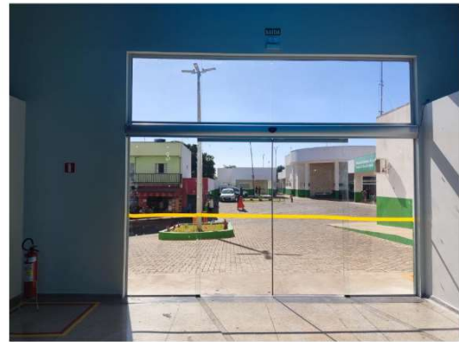
RECEPÇÃO CENTRAL – INSTALAÇÃO DE NOVA PORTA DE VIDRO AUTOMÁTICA
