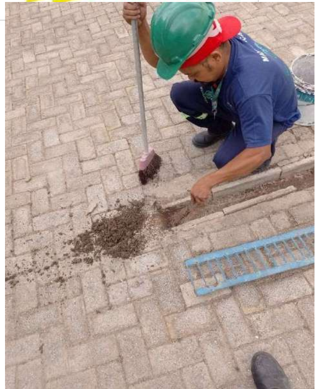
LIMPEZA DE GRELHAS DE ÁGUAS PLUVIAIS
