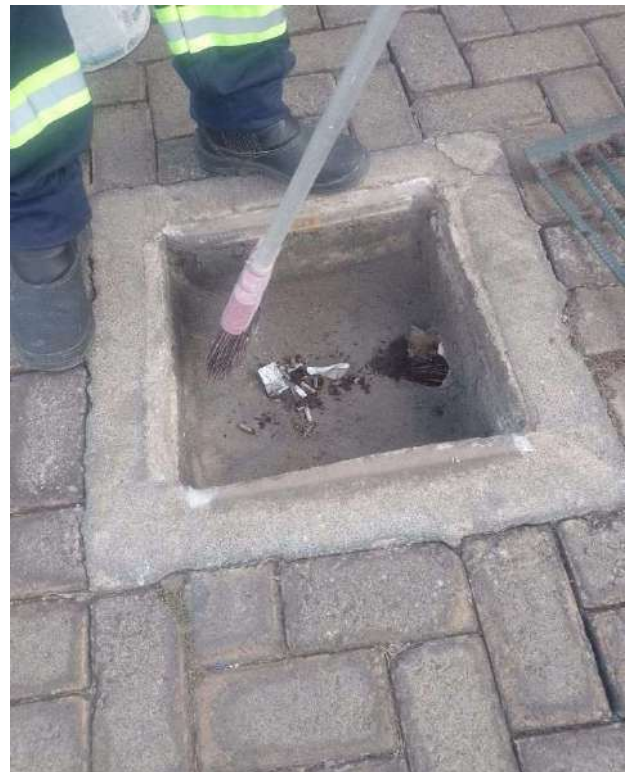
LIMPEZA DE GRELHAS DE ÁGUAS PLUVIAIS
