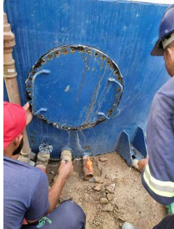
VEDAÇÃO DE BOCA DE VISITA DO RESERVATÓRIO DE ÁGUA
