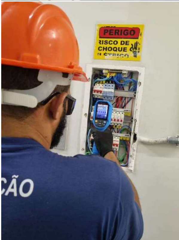
INSPEÇÃO DE QUADROS ELÉTRICOS
