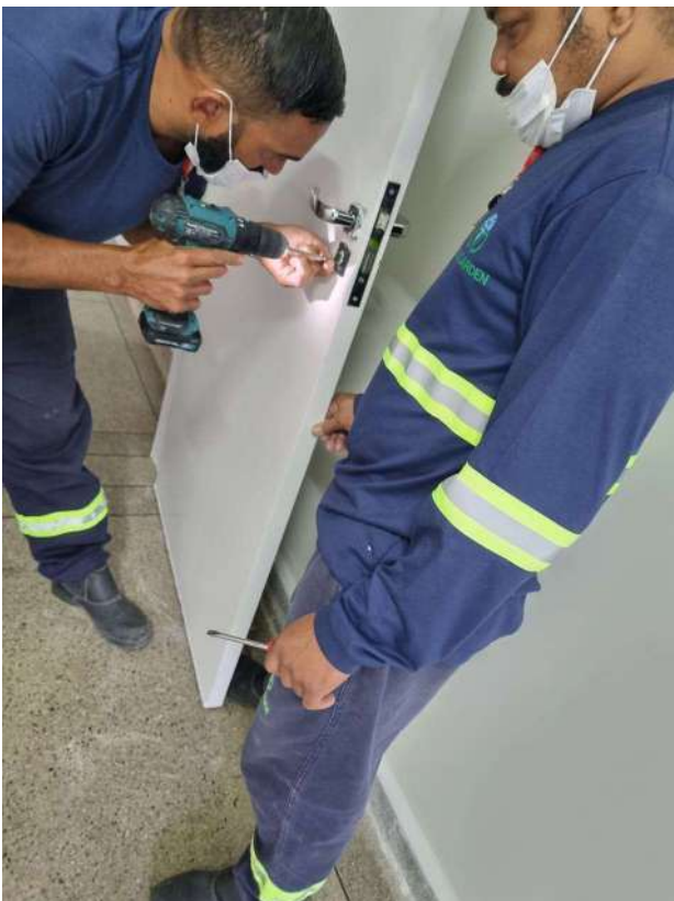
REPARO NA FECHADURA DA PORTA DO REPOUSO DOS MÉDICOS NA UTI
