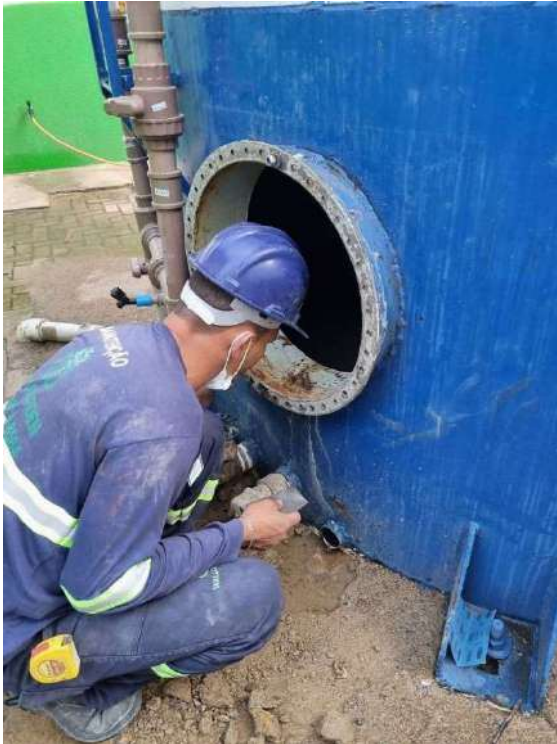
VEDAÇÃO DE BOCA DE VISITA DO RESERVATÓRIO DE ÁGUA
