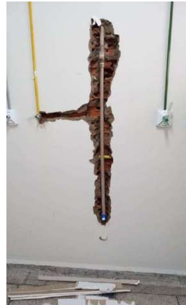
RETIRADA DE VAZAMENTO NA SALA DE EQUIPAMENTOS NA UTI
