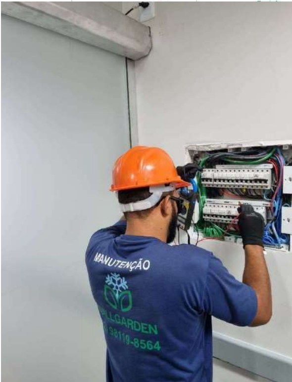
INSPEÇÃO DE QUADROS ELÉTRICOS
