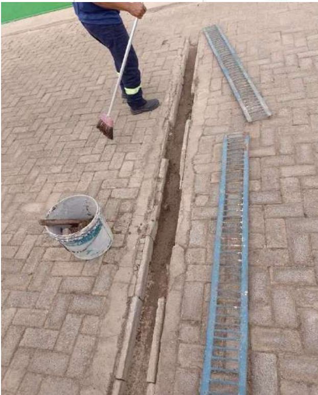
LIMPEZA DE GRELHAS DE ÁGUAS PLUVIAIS
