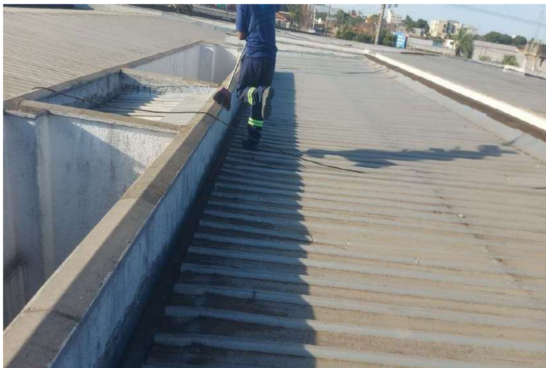
LIMPEZA DE CALHAS
