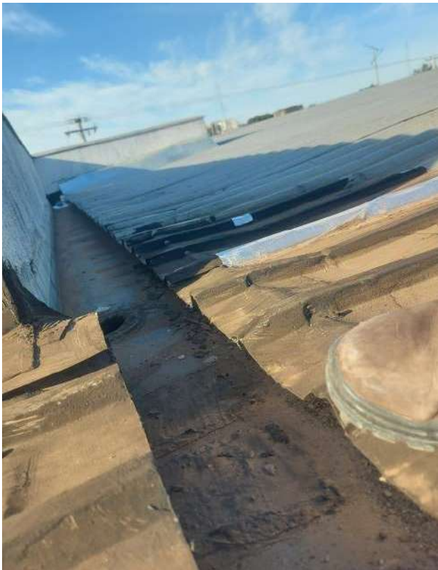
LIMPEZA DE CALHAS
