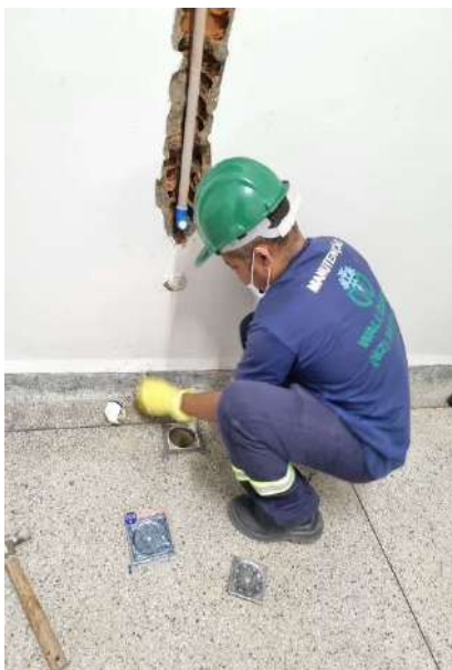
RETIRADA DE VAZAMENTO NA SALA DE EQUIPAMENTOS NA UTI
