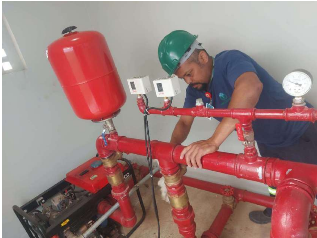
LIMPEZA DA CASA DE BOMBAS
