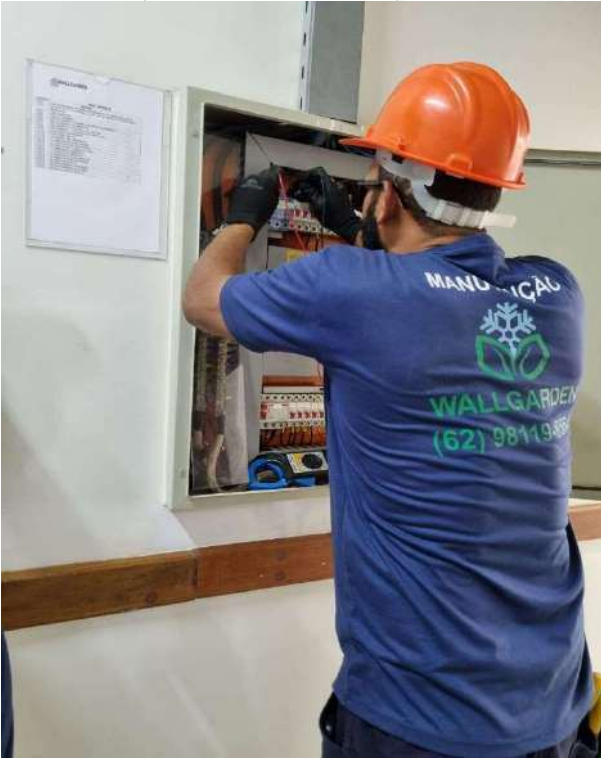
INSPEÇÃO DE QUADROS ELÉTRICOS
