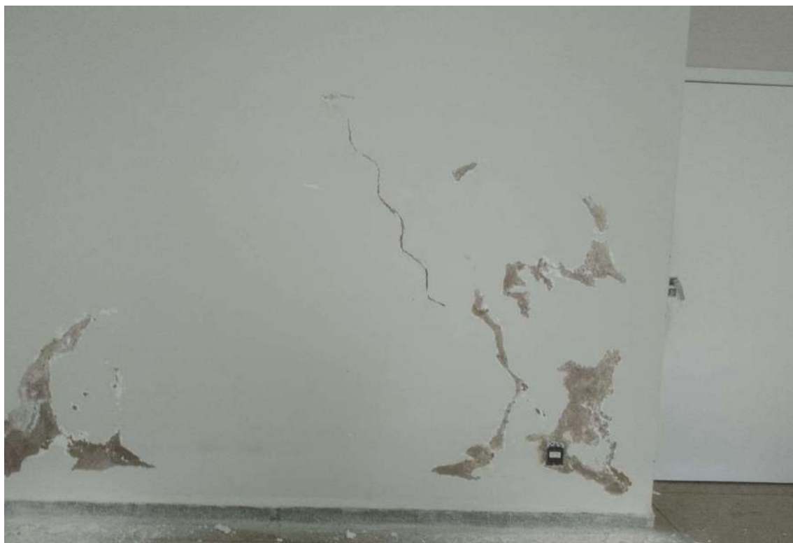
IMPERMEABILIZAÇÃO E REPARO DE PINTURA NO REPOUSO DOS MÉDICOS DA UTI
