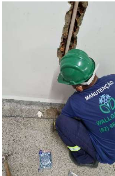
RETIRADA DE VAZAMENTO NA SALA DE EQUIPAMENTOS NA UTI
