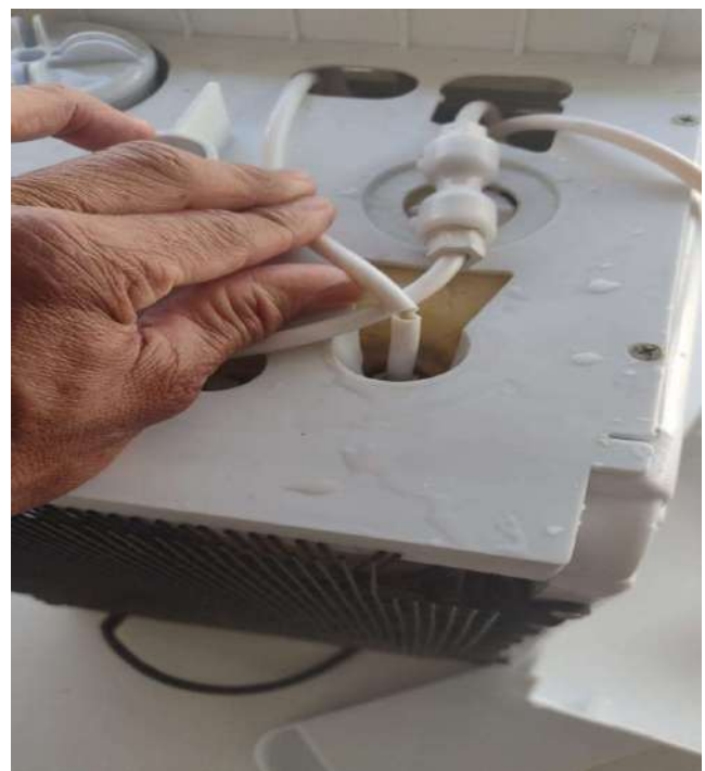
VEDAÇÃO DE BOCA DE VISITA DO RESERVATÓRIO DE ÁGUA
