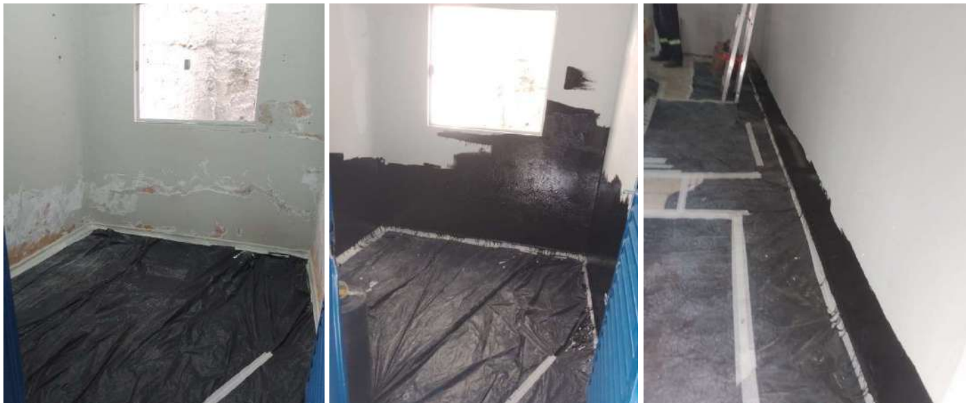
REPARO DE PINTURA NO ALMOXARIFADO DA FARMÁCIA
