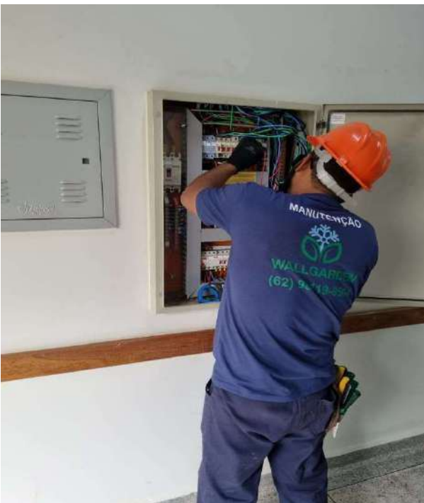
INSPEÇÃO DE QUADROS ELÉTRICOS
