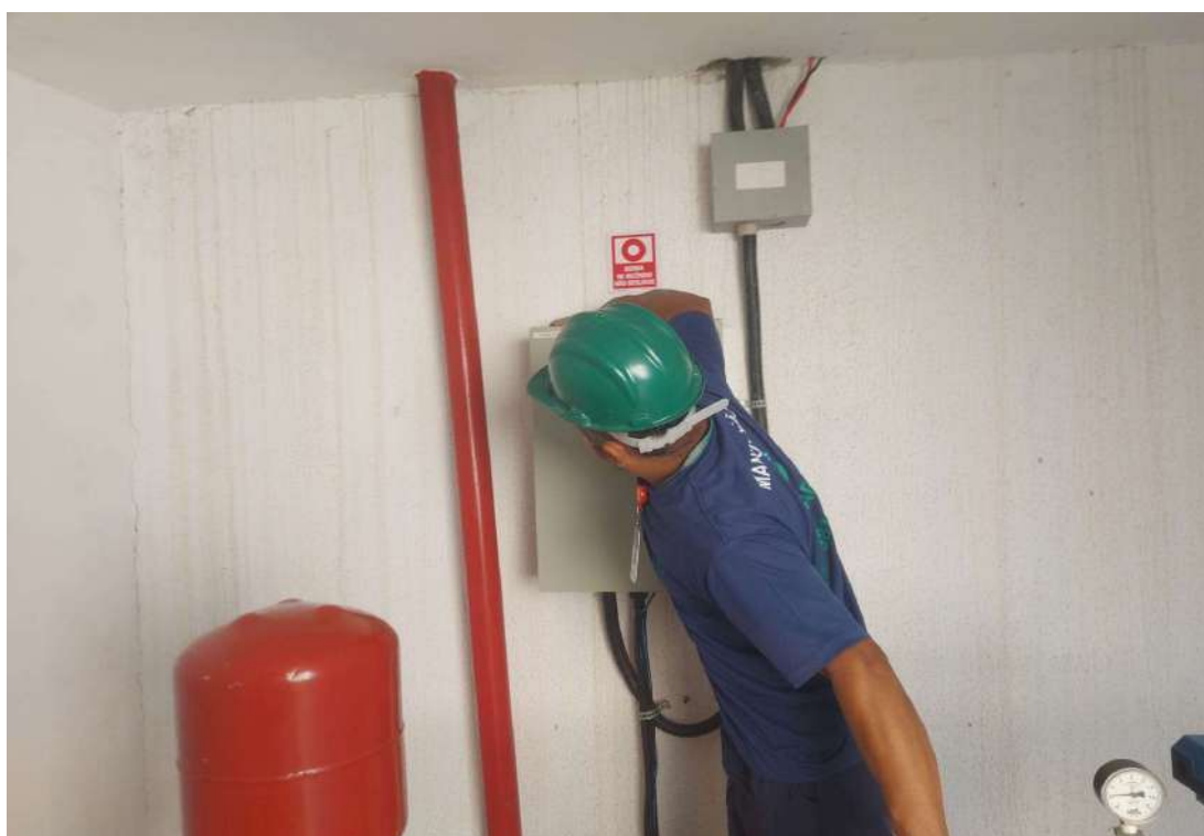
LIMPEZA DA CASA DE BOMBA
