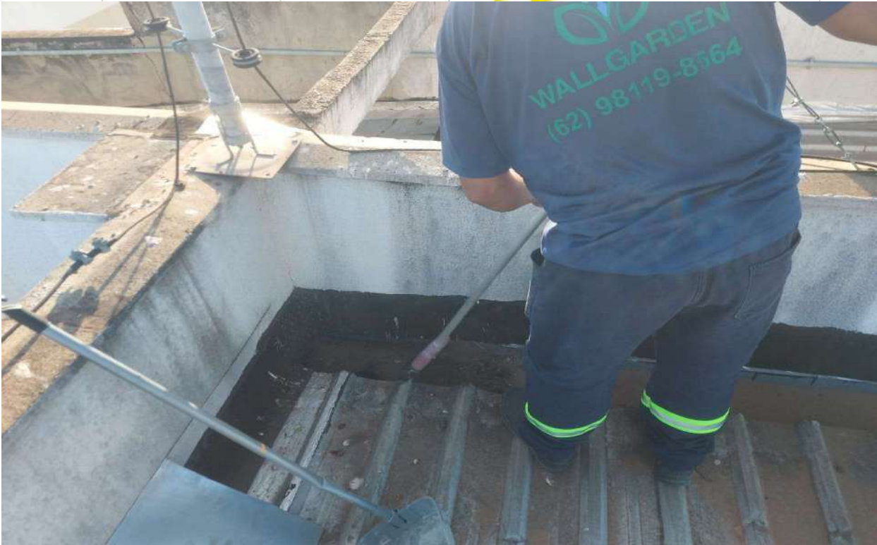
LIMPEZA DE CALHAS
