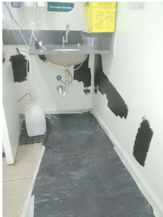
Impermeabilização e revitalização de pintura do laboratório
