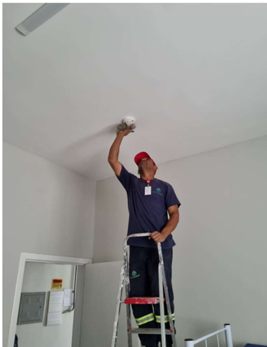
Limpeza e verificação das botoeiras, sensores, alarmes e hidrante
