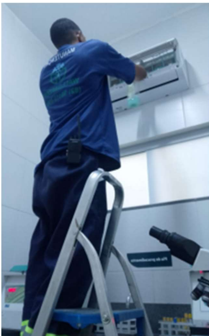
Manutenções preventivas em equipamentos de ar condicionado do tipo split
