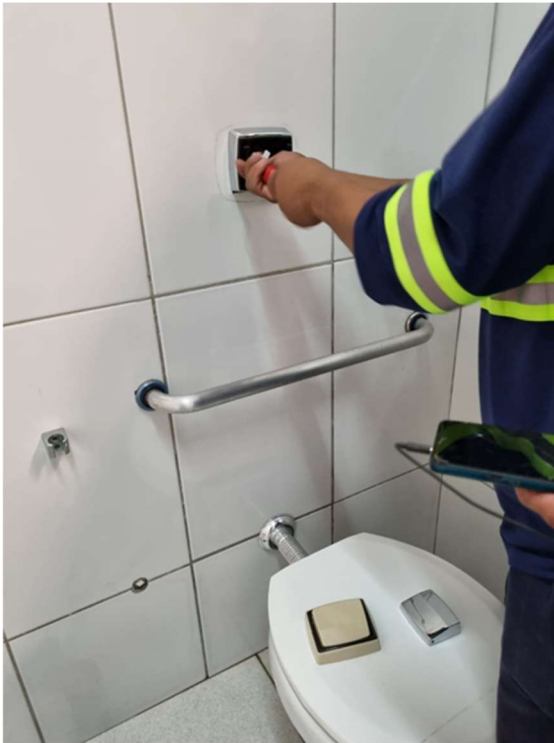
Regulagem do mecanismo de descarga e desentupimento de ralo
