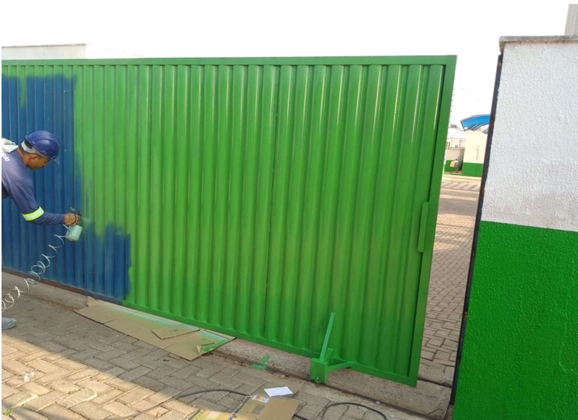
Pintura do portão de carga e descarga
