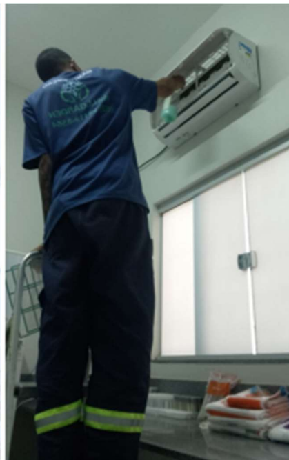
Manutenções preventivas em equipamentos de ar condicionado do tipo split
