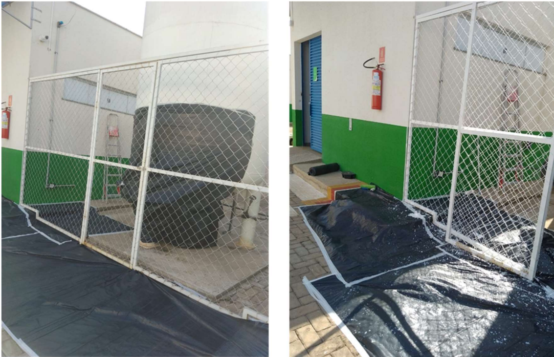
Pintura do alambrado de proteção do tanque criogênico
