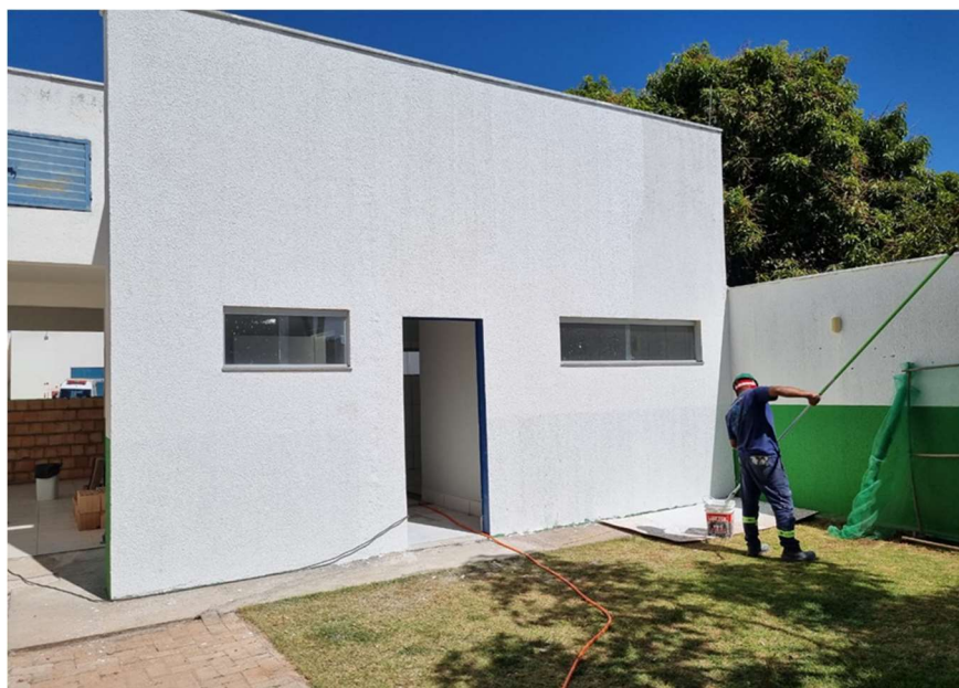
Pintura de fachada do novo repouso de colaboradores
