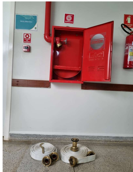
Limpeza e verificação das botoeiras, sensores, alarmes e hidrante
