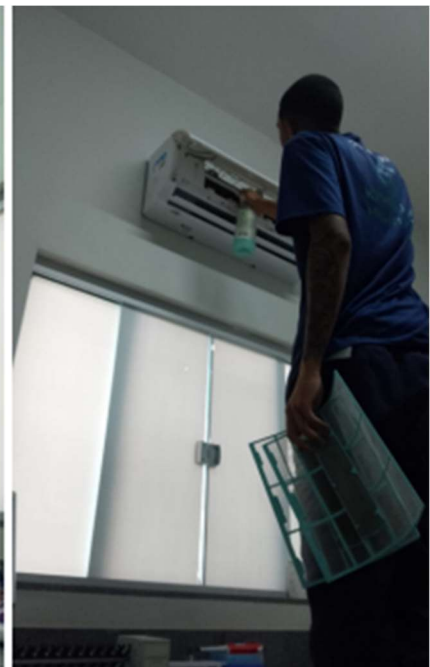
Manutenções preventivas em equipamentos de ar condicionado do tipo split
