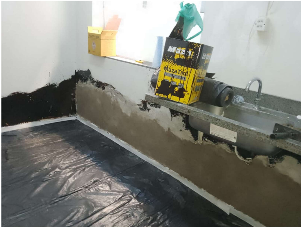
Impermeabilização e pintura da sala de medicamentos da enfermaria clínica
