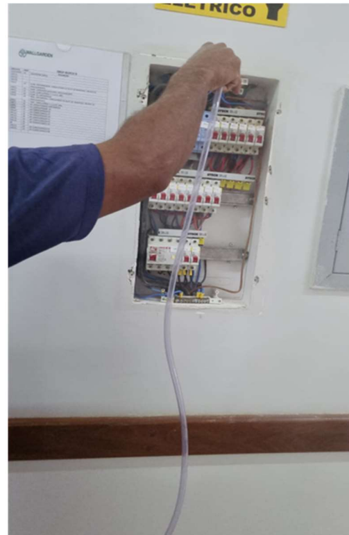
Inspeção e limpeza de quadros elétricos
