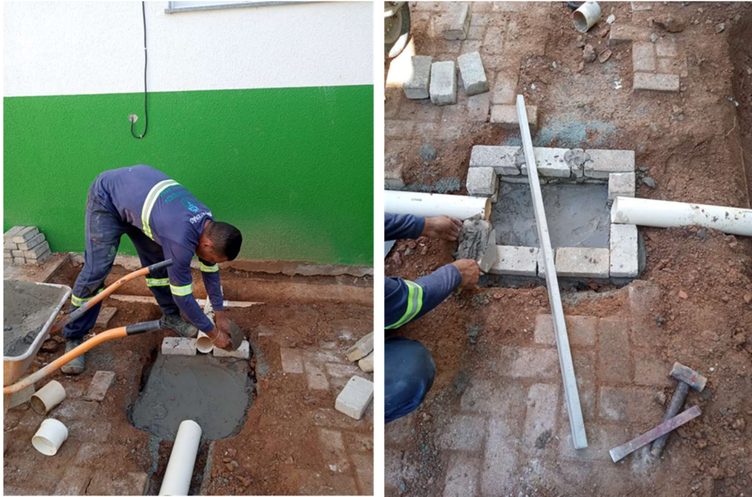
Construção de caixa de passagem de águas pluviais
