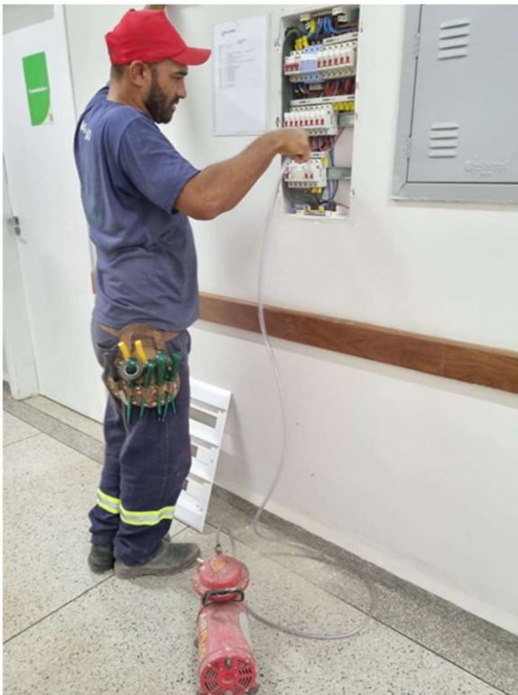
Inspeção e limpeza de quadros elétricos
