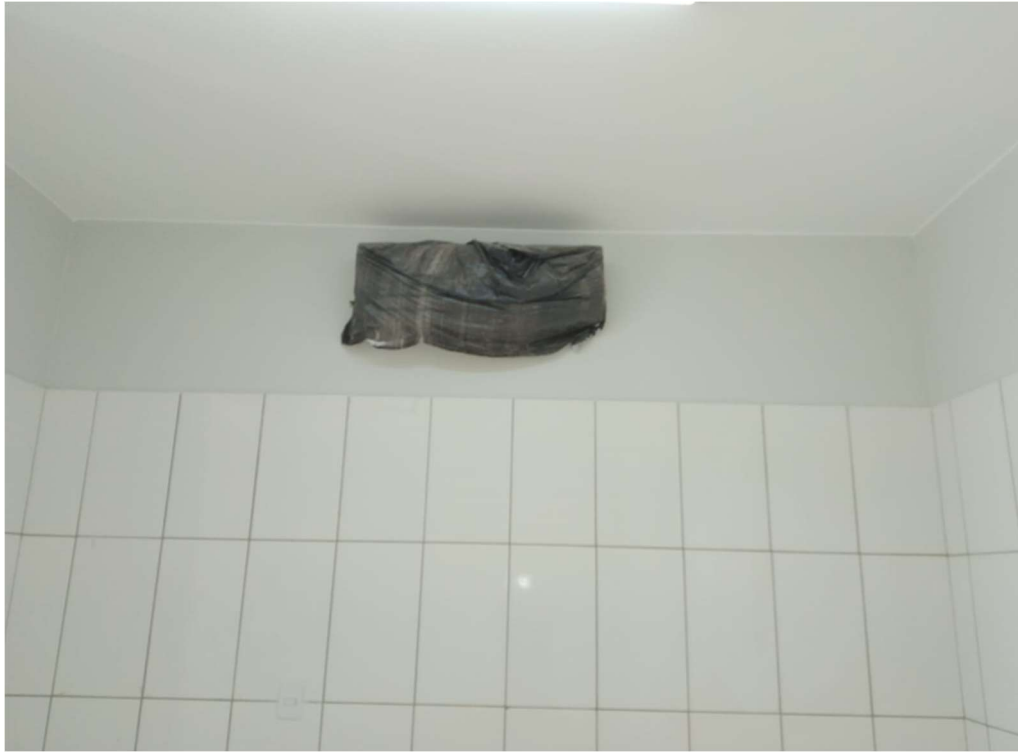
Assentamento de revestimento e pintura do novo repouso de colaboradores
