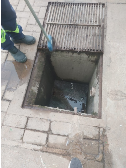
LIMPEZA DE CAIXA DE PASSAGEM DE ÁGUAS PLUVIAIS
