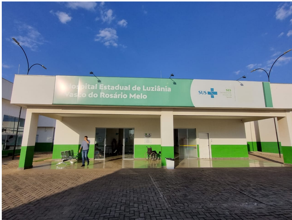
INSTALAÇÃO DE REFLETORES DE LED RGB NA FACHADA FRONTAL
