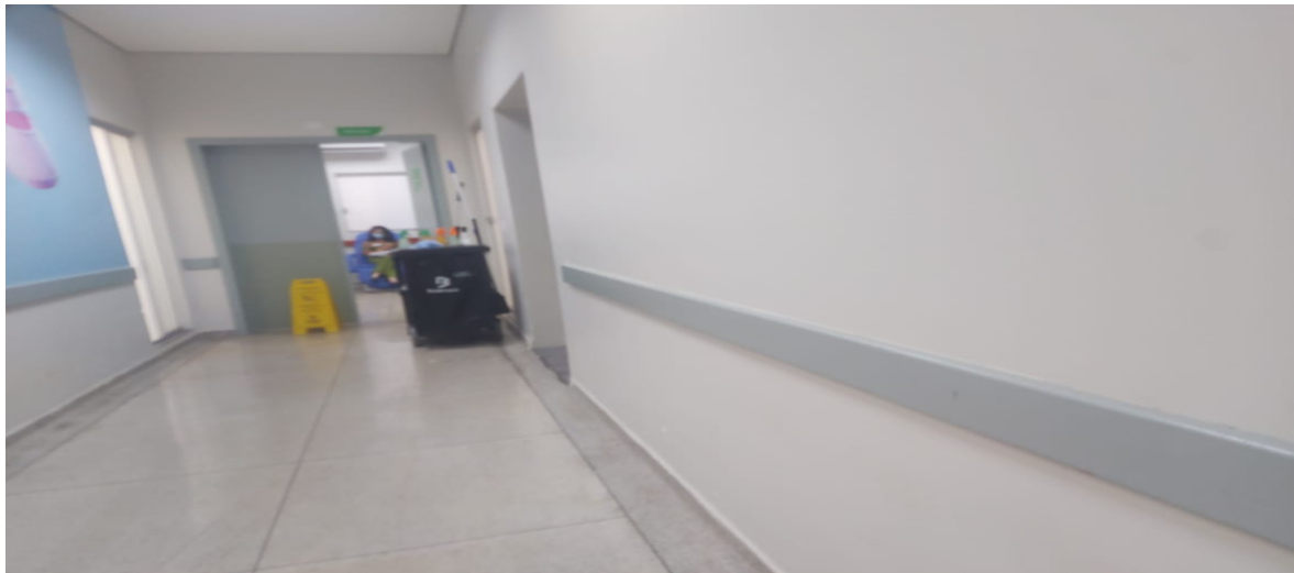
REPARO DE PINTURA DOS BATE MACAS NA ENFERMARIA CLÍNICA
