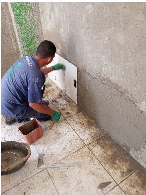
ASSENTAMENTO DE REVESTIMENTO CERÂMICO NO NOVO REPOUSO
