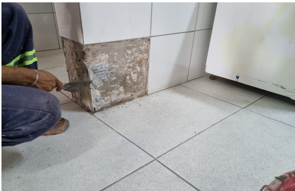
REPOSIÇÃO DE REVESTIMENTOS CERÂMICOS QUEBRADOS NA COZINHA
