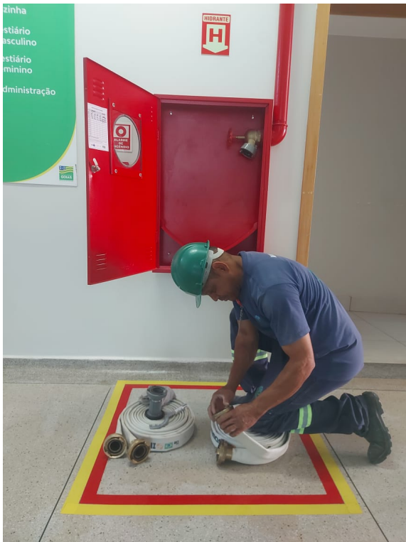
LIMPEZA E VERIFICAÇÃO DAS BOTOEIRAS, SENSORES, ALARMES E HIDRANTE
