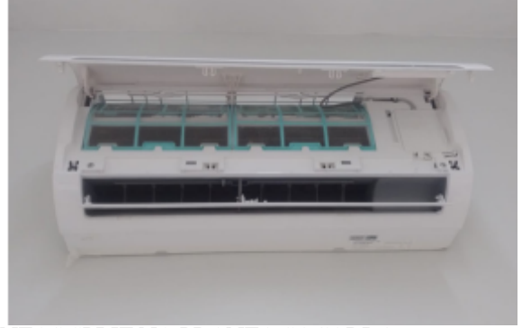
MANUTENÇÕES PREVENTIVAS EM EQUIPAMENTOS SPLIT NO PRONTO SOCORRO
