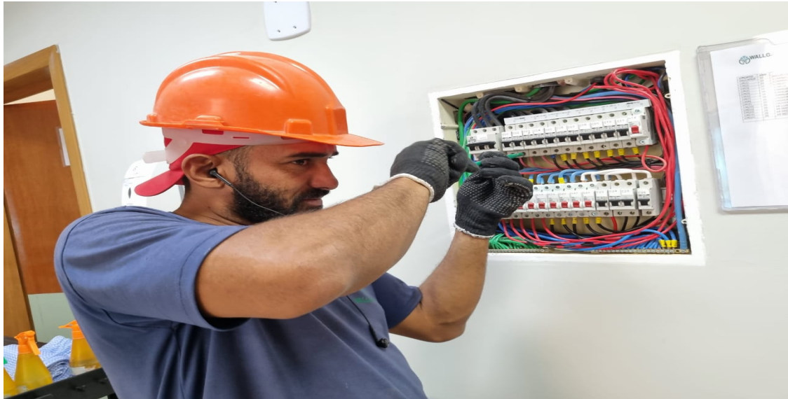
INSPEÇÃO DE QUADROS ELÉTRICOS
