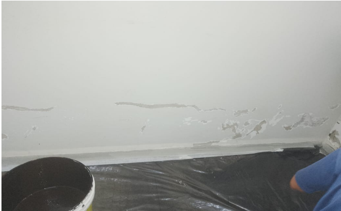
REPARO DE PINTURA NOS CONSULTÓRIOS DO PRONTO SOCORRO
