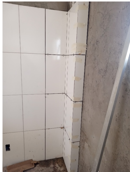
ASSENTAMENTO DE REVESTIMENTO CERÂMICO NO NOVO REPOUSO
