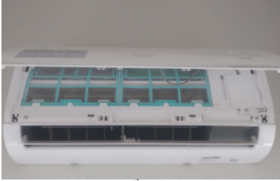
MANUTENÇÕES PREVENTIVAS EM EQUIPAMENTOS SPLIT NO PRONTO SOCORRO
