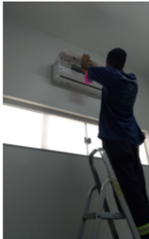
MANUTENÇÕES PREVENTIVAS EM EQUIPAMENTOS SPLIT NO SETOR ABULATORIAL
