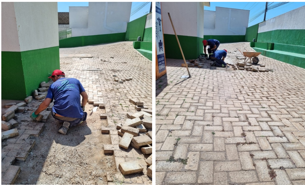
NIVELAMENTO DE PISO EXTERNO
