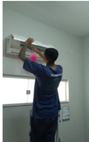
MANUTENÇÕES PREVENTIVAS EM EQUIPAMENTOS SPLIT NO SETOR ABULATORIAL
