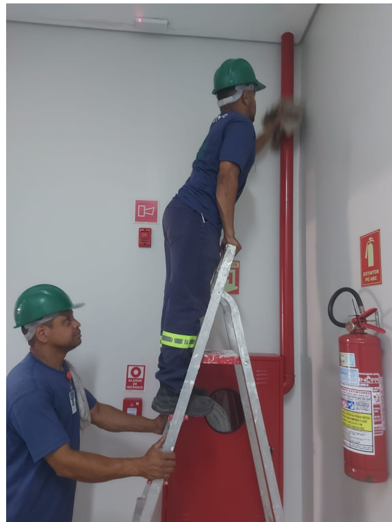
LIMPEZA E VERIFICAÇÃO DAS BOTOEIRAS, SENSORES, ALARMES E HIDRANTE
