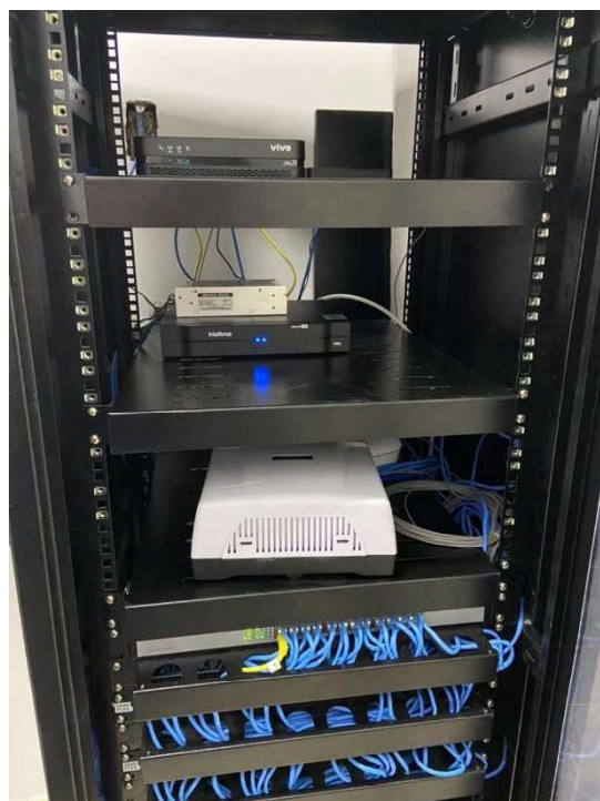
Figura 7.a – Hack estruturado com redes, alarme e monitoramento.
