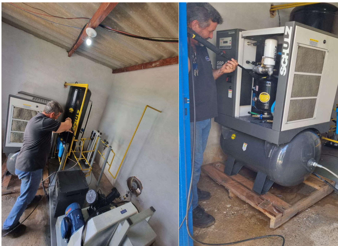
Manutenção preventiva no sistema de ar comprimido
