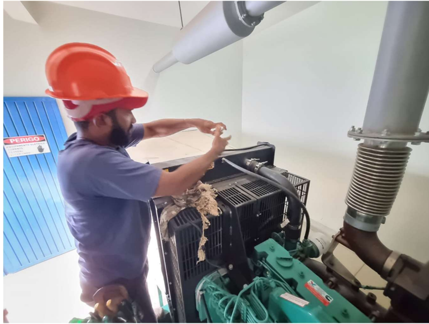
Manutenção preventiva dos grupos geradores
