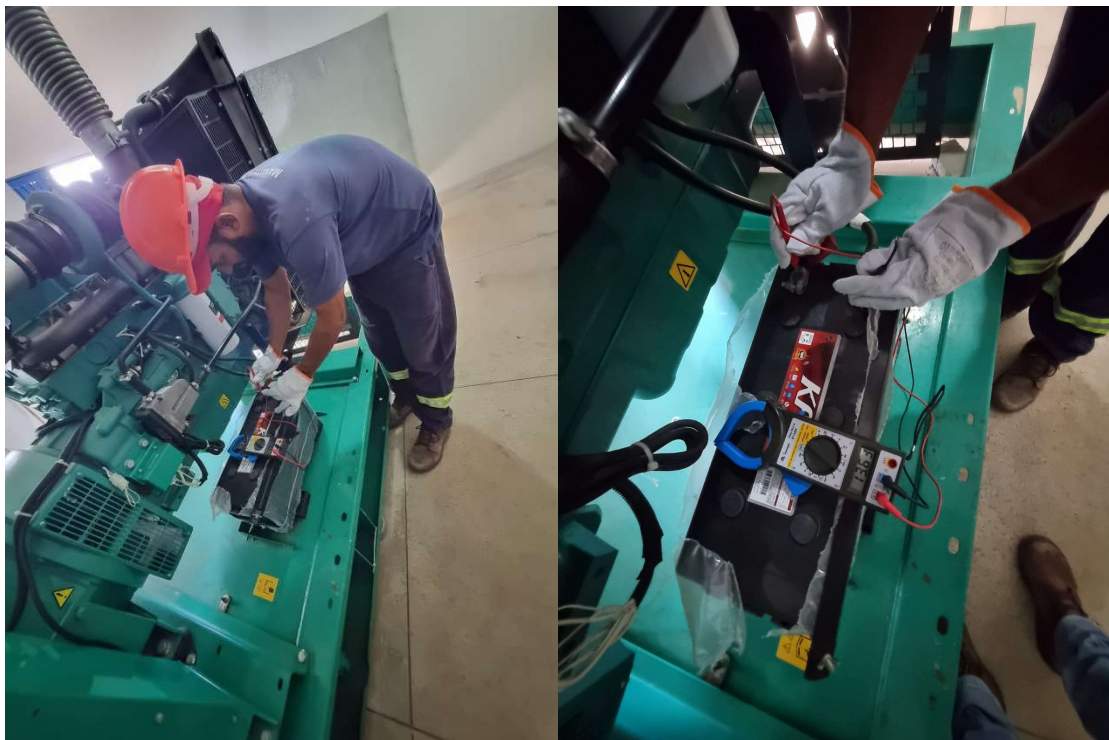
Manutenção preventiva dos grupos geradores
