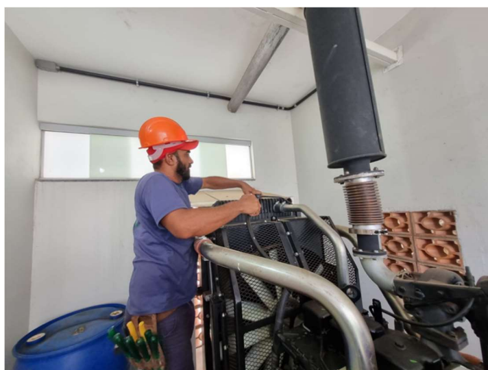
Manutenção preventiva dos grupos geradores
