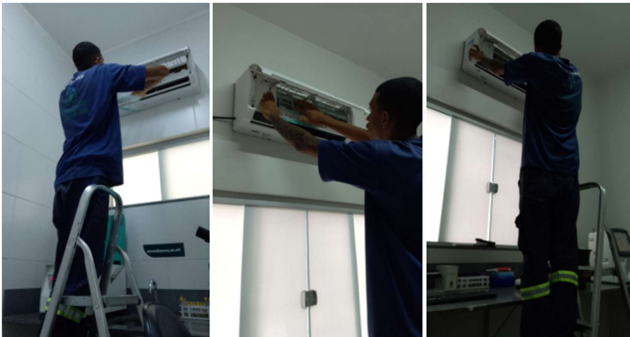
Manutenções preventivas em equipamentos de ar condicionado
