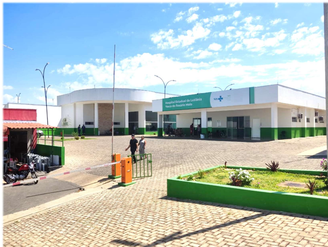
Figura 2. Fachada frontal atual Fonte: Autor.
