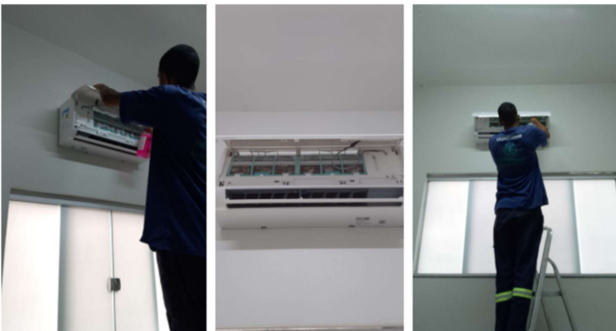
Manutenções preventivas em equipamentos de ar condicionado
