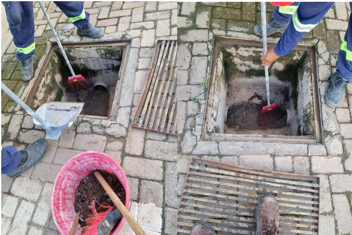
Limpeza de caixas de passagem
