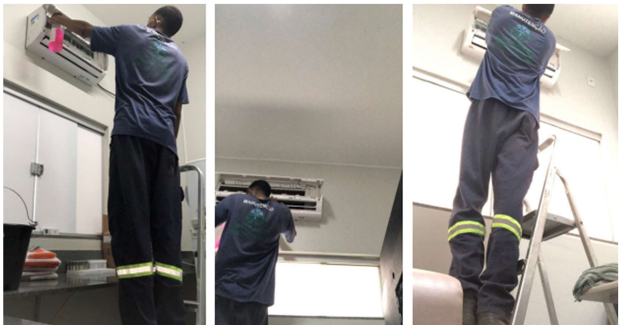
Manutenções preventivas em equipamentos de ar condicionado
