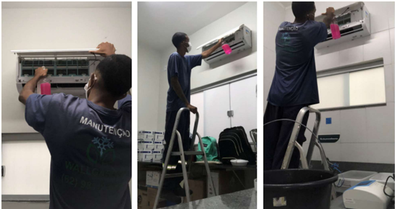
Manutenções preventivas em equipamentos de ar condicionado
