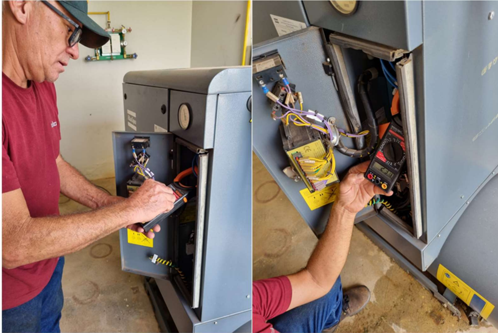
Manutenção preventiva no sistema de ar comprimido
