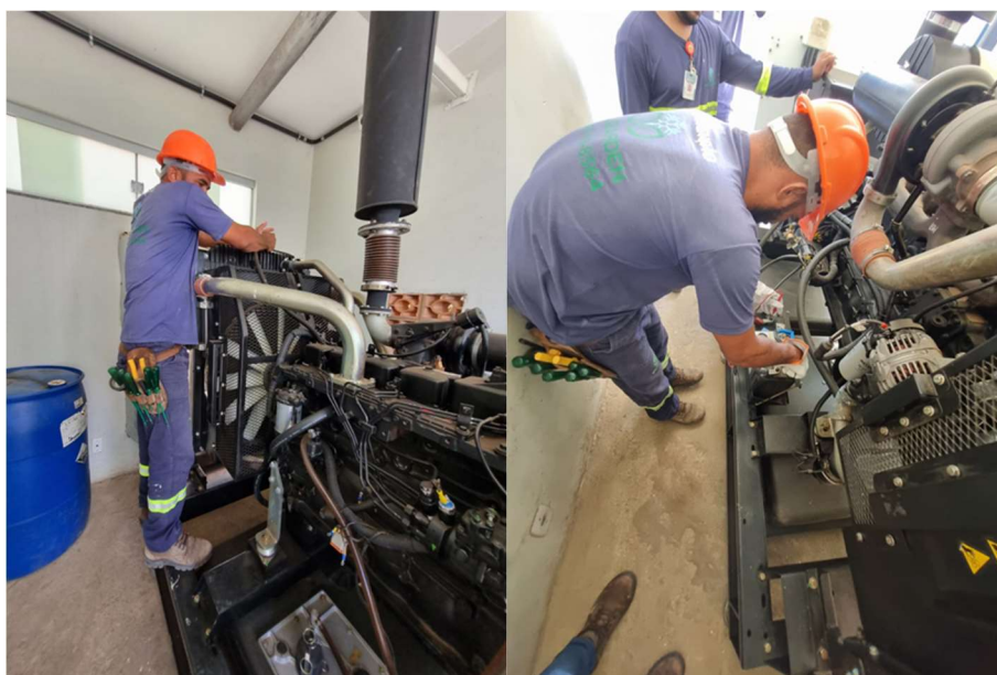
Manutenção preventiva dos grupos geradores
