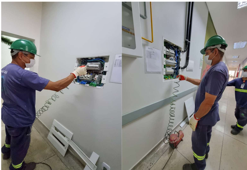
Limpeza de quadros elétricos
