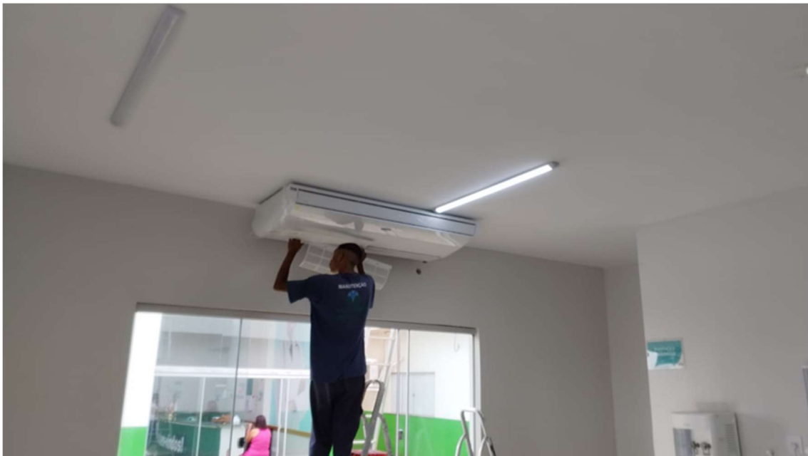
Instalação de ar condicionado na recepção do Pronto Socorro
