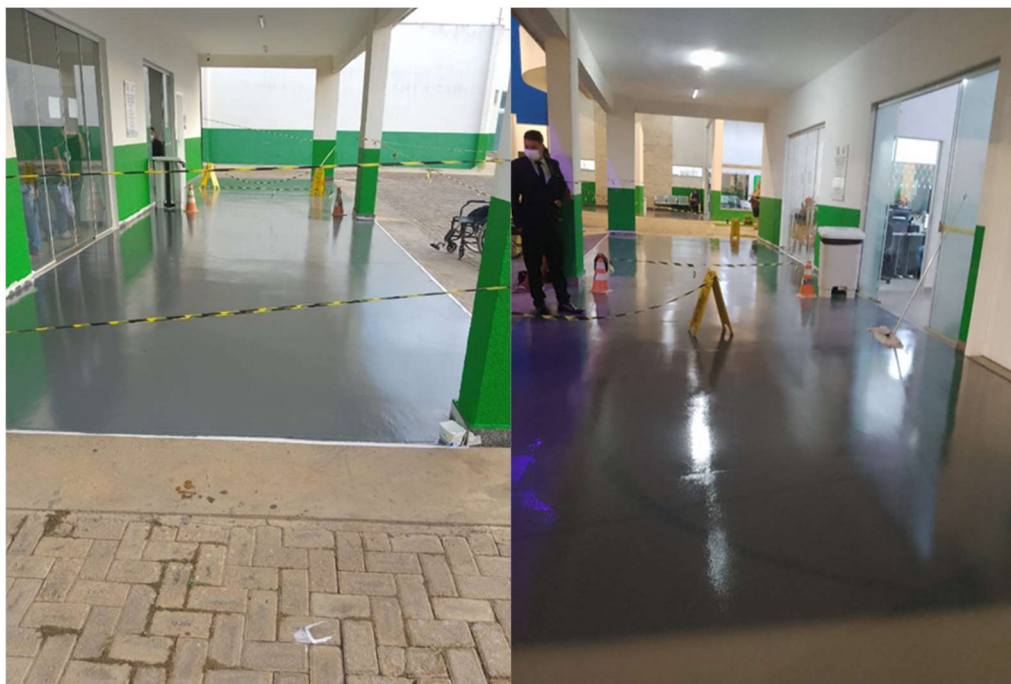
Pintura de piso e paredes do Pronto Socorro
