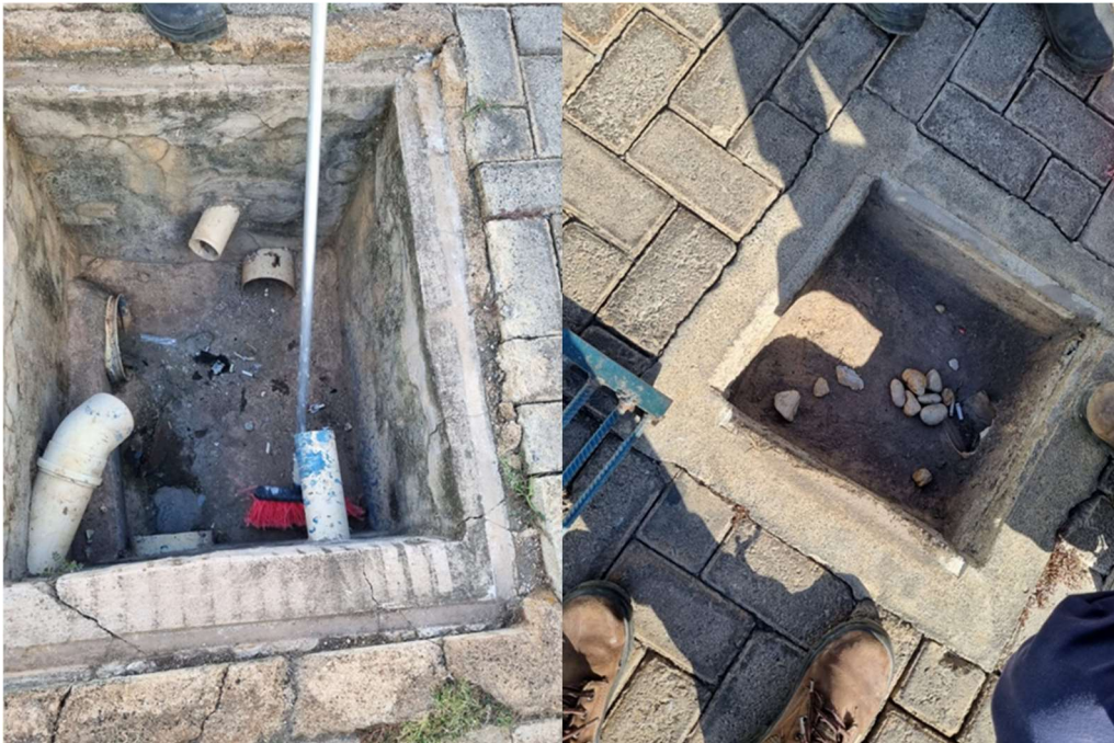
Limpeza de caixas de passagem
