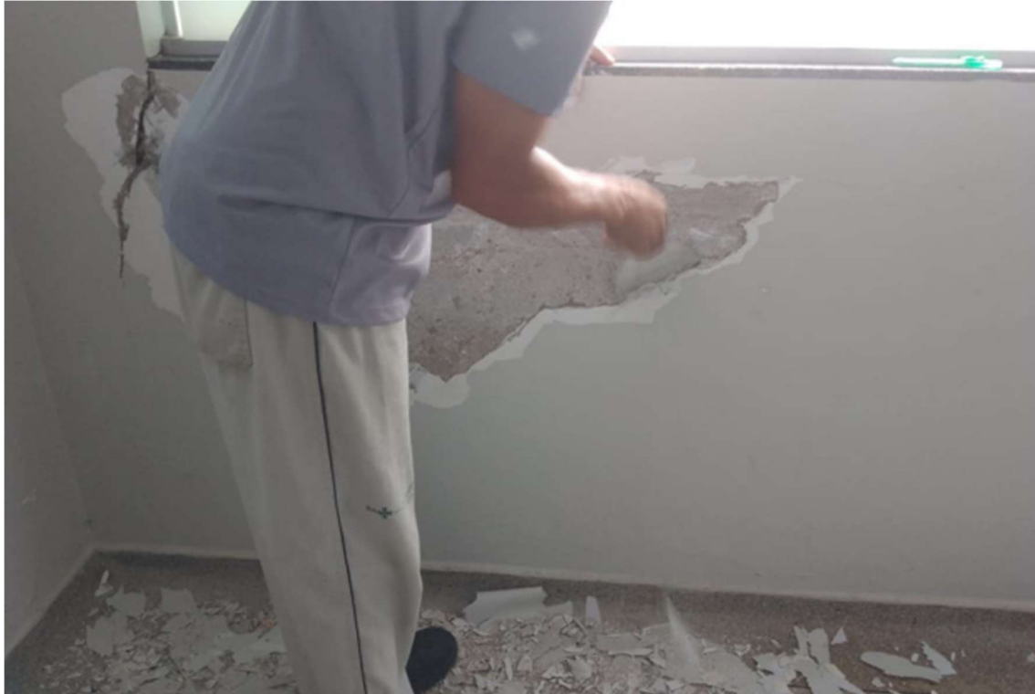
REPARO DE PINTURA E IMPERMEABILIZAÇÃO DO LACTÁRIO
