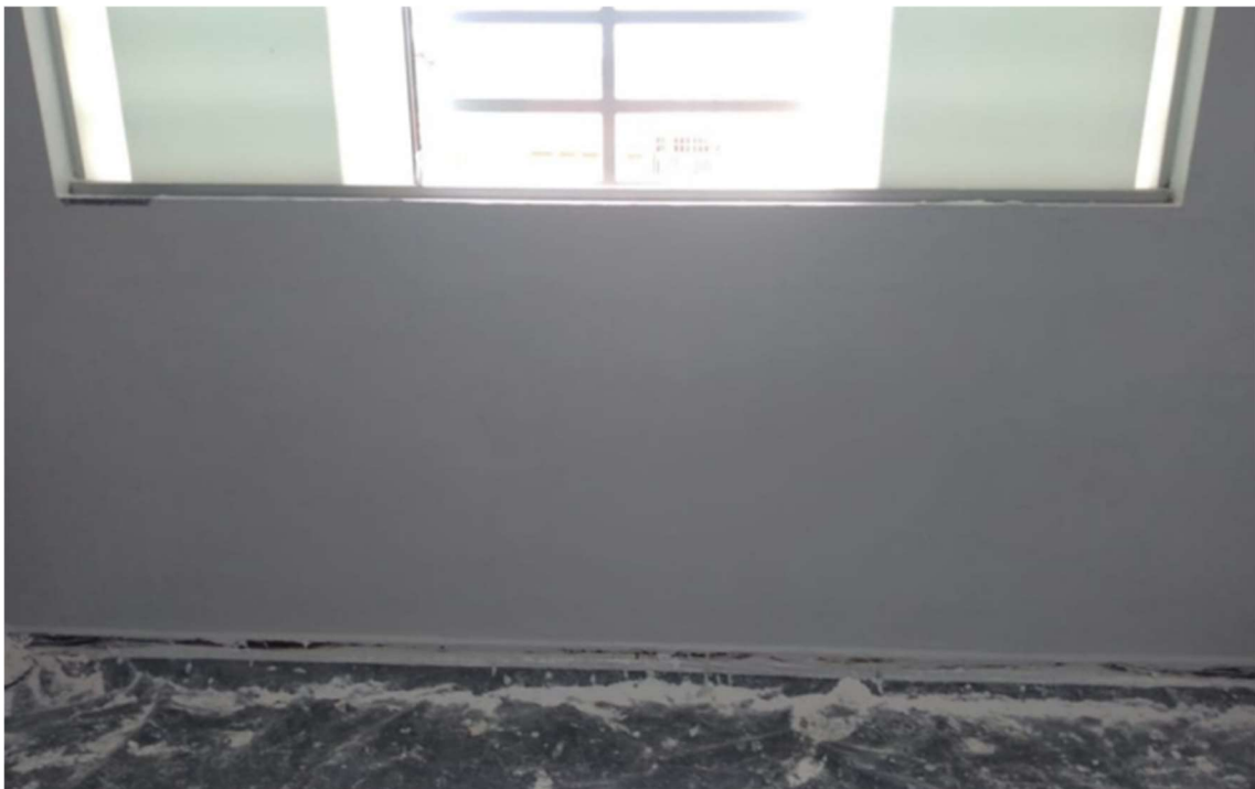
REPARO DE PINTURA E IMPERMEABILIZAÇÃO DO LACTÁRIO
