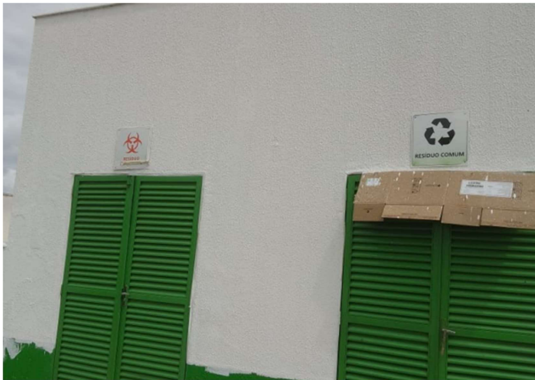
PINTURA DA FACHADA DO ABRIGO DE RESÍDUOS
