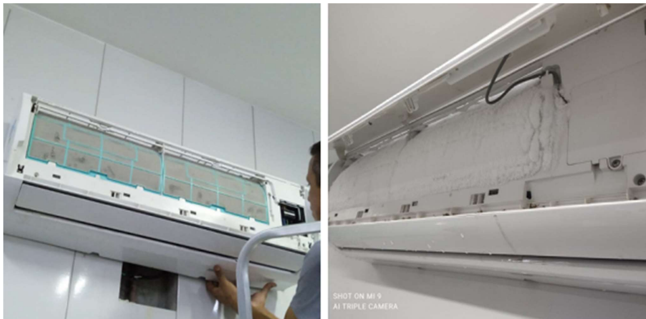
MANUTENÇÃO PREVENTIVA DOS EQUIPAMENTOS DE AR CONDICIONADO SPLIT
