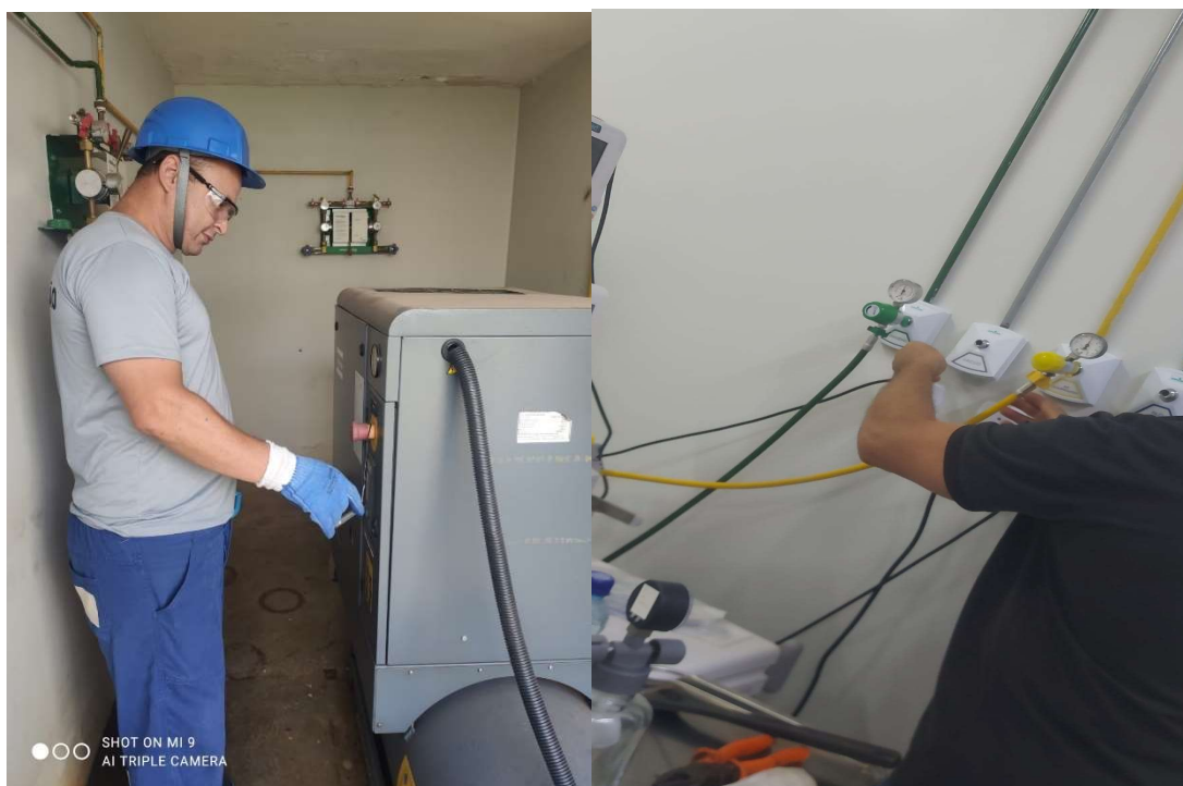
MANUTENÇÃO PREVENTIVA NO SISTEMA DE AR COMPRIMIDO
