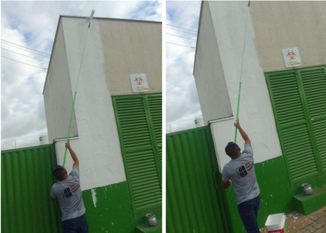
PINTURA DA FACHADA DO ABRIGO DE RESÍDUOS
