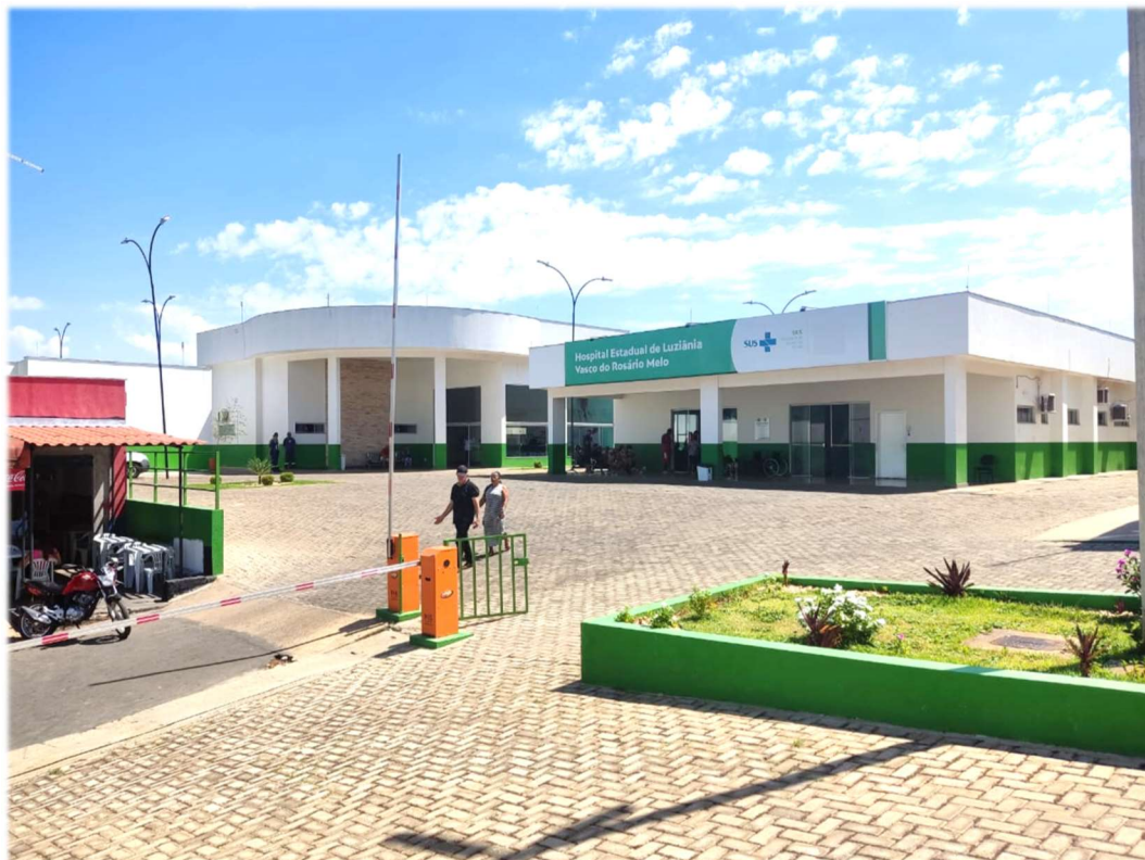
Figura 2. Fachada frontal atual Fonte: Autor.
