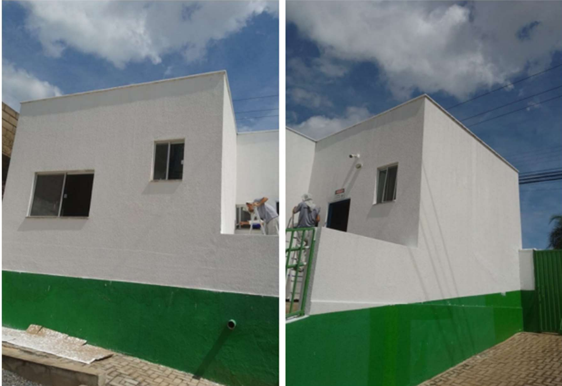
PINTURA DA FACHADA DO ABRIGO DE RESÍDUOS
