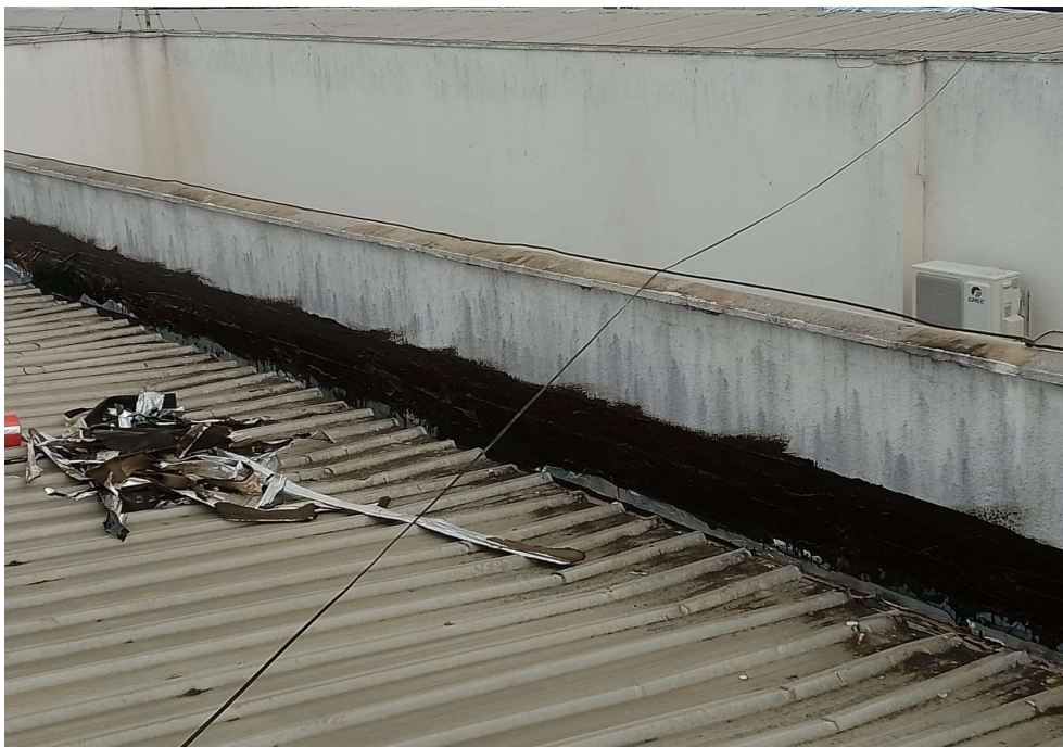
MANUTENÇÃO DO TELHADO
