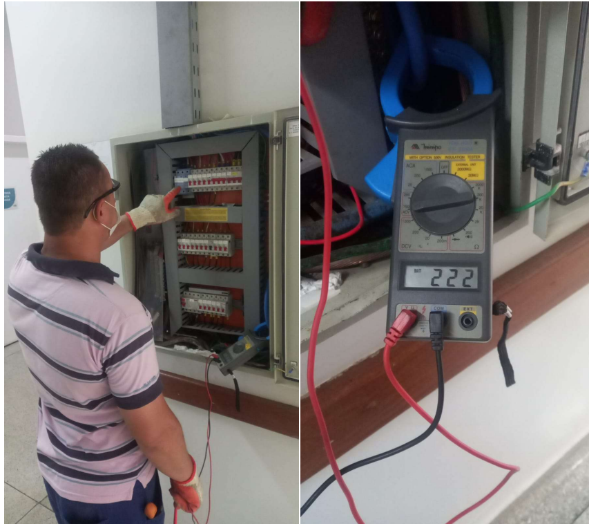
INSPEÇÃO DOS QUADROS ELÉTRICOS
