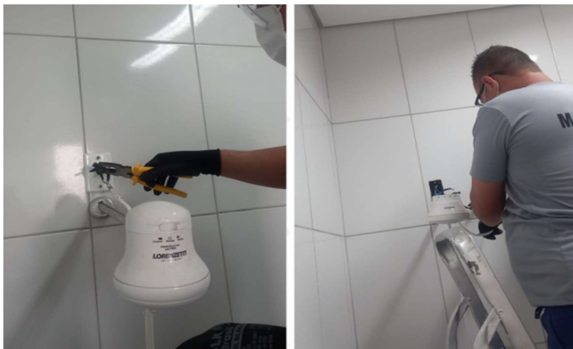
SUBSTITUIÇÃO DE CHUVEIRO
