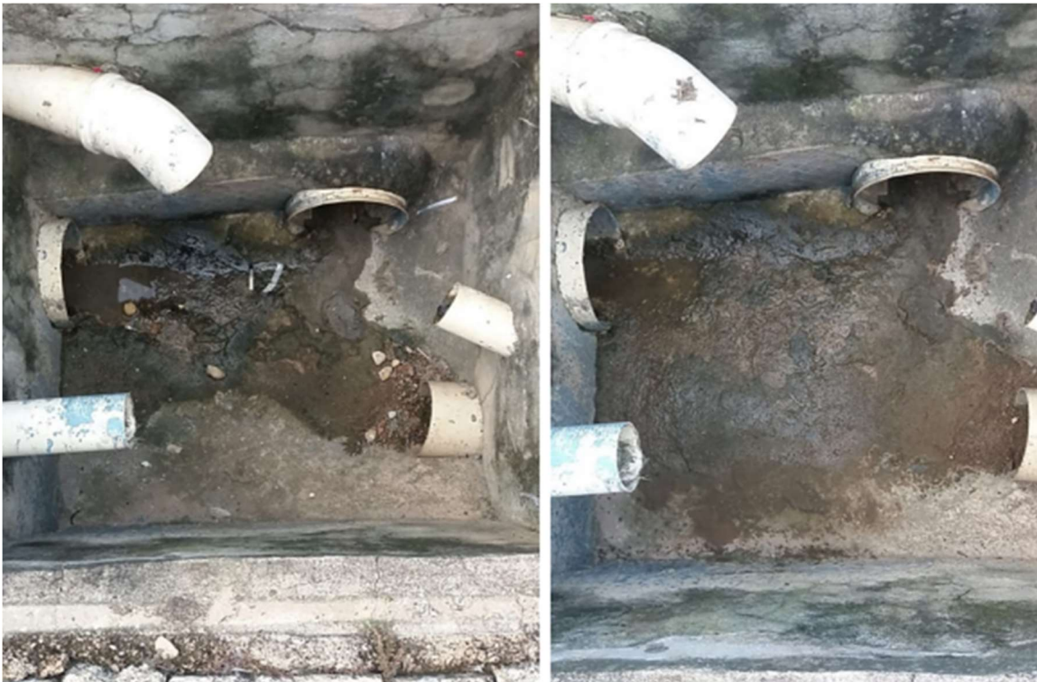
LIMPEZA DAS CAIXAS DE PASSAGEM DE ÁGUAS PLUVIAIS
