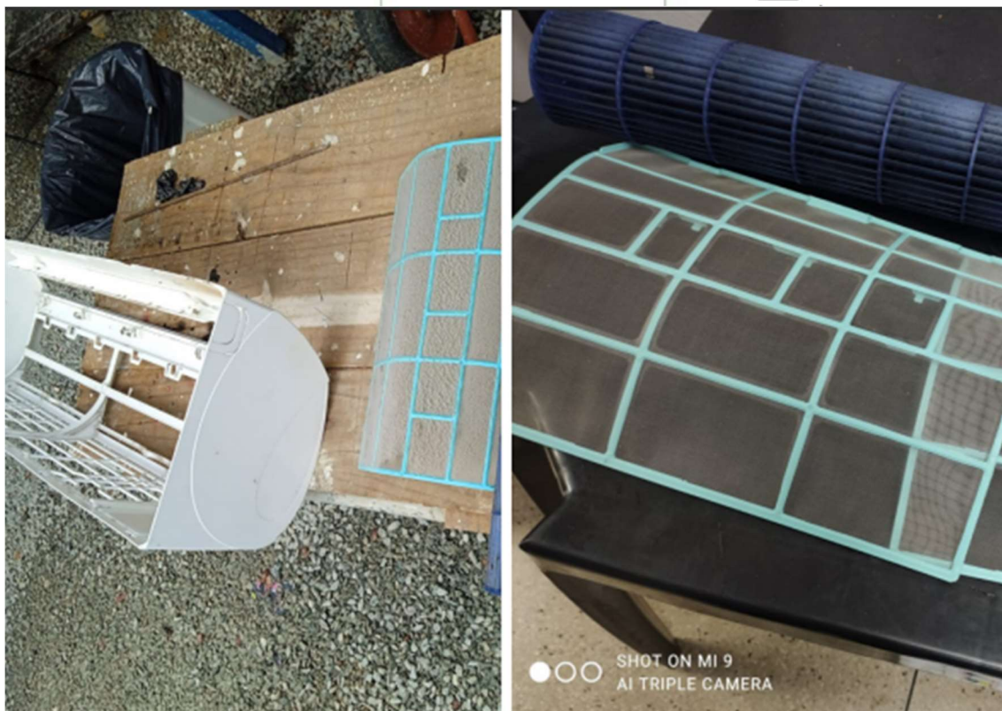
MANUTENÇÃO PREVENTIVA DOS EQUIPAMENTOS DE AR CONDICIONADO
