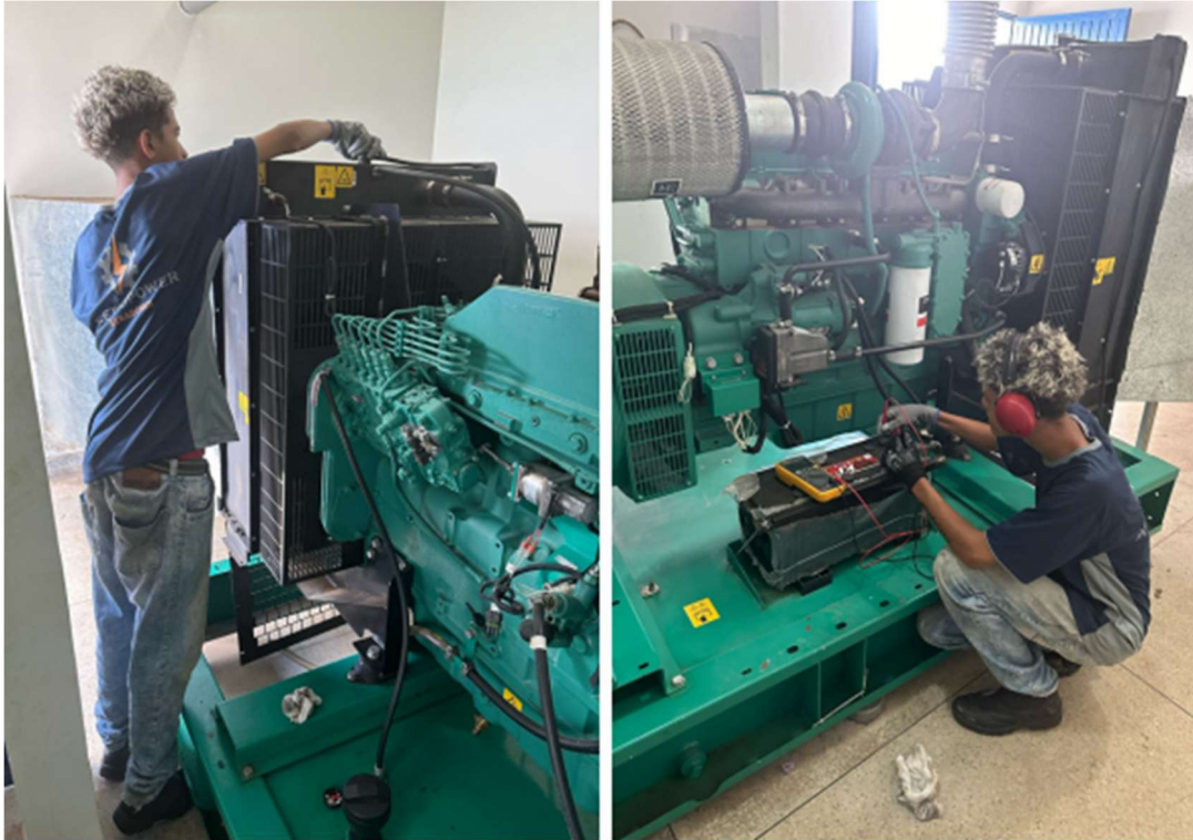
MANUTENÇÃO PREVENTIVA DO GRUPO GERADOR
