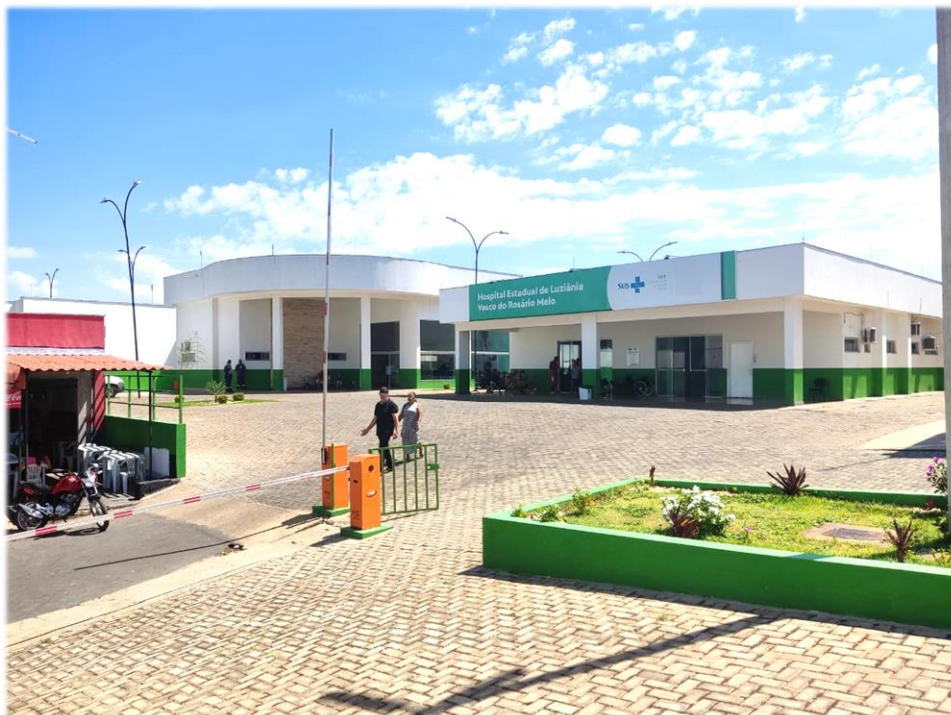
Figura 2. Fachada frontal atual
