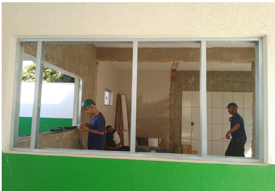
Fechamento dos vãos em drywall do ambiente 01 do novo repouso
