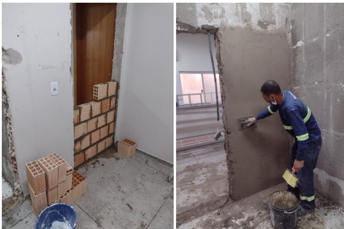
Clínica Cirúrgica: adequação de estrutura física para instalação de novo posto de enfermagem (conforme orientações da SUVISA)
