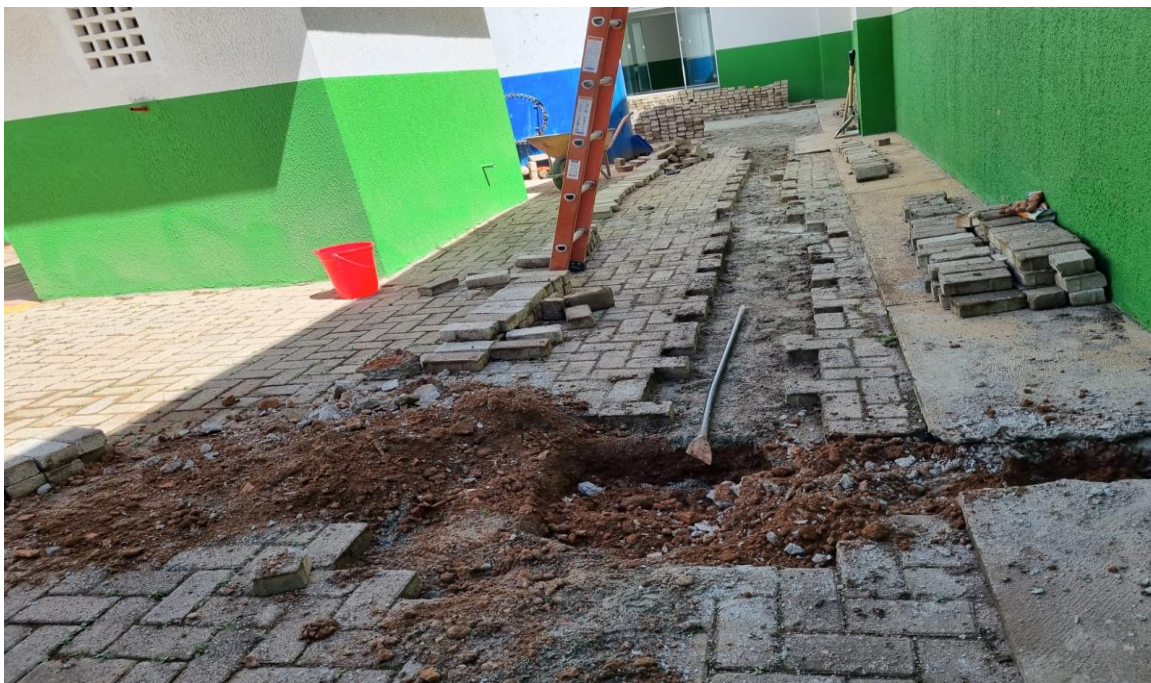
Construção de caixa de passagem para água pluvial
