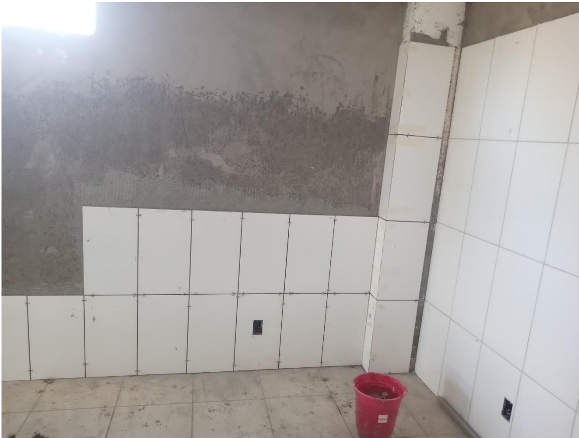
Assentamento de revestimento cerâmico (ambiente 02 do novo repouso)
