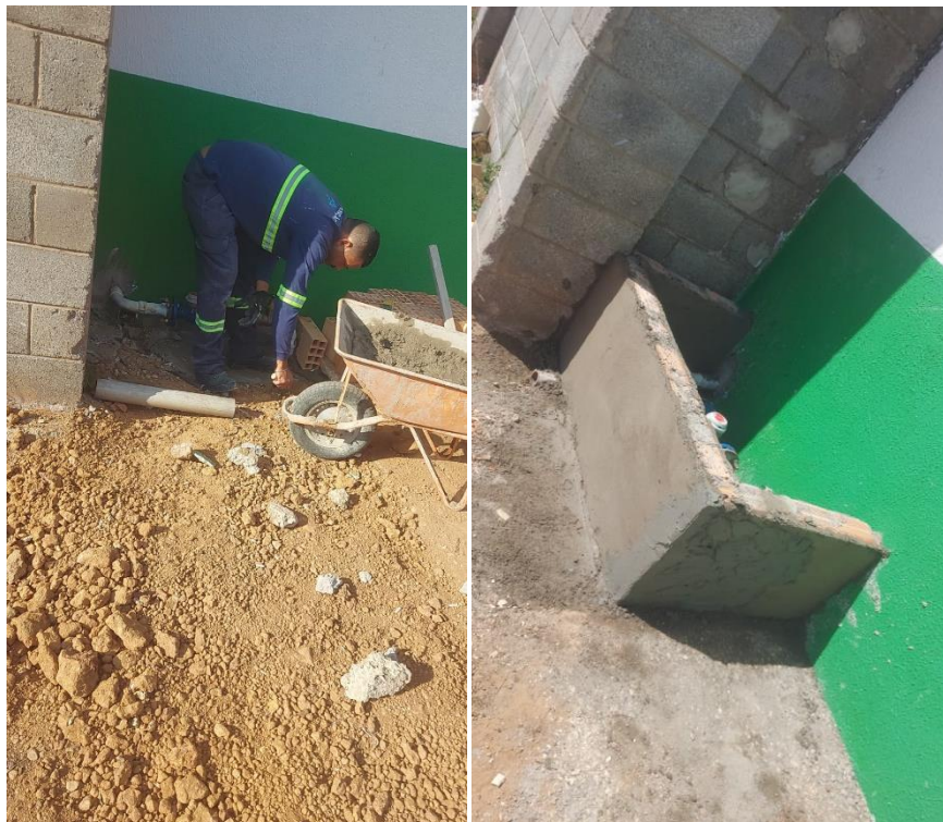
Área Externa: construção de mureta para hidrômetro
