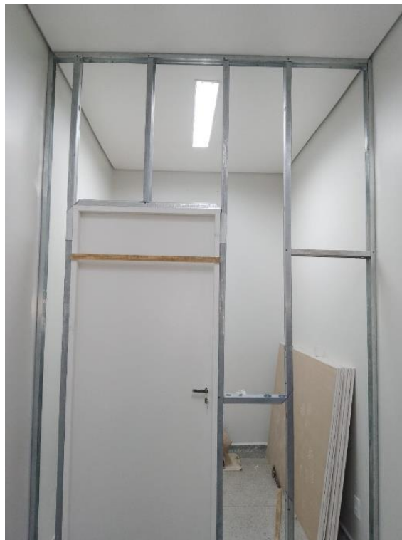
Centro Cirúrgico: instalação de divisória com porta na sala de medicamentos
