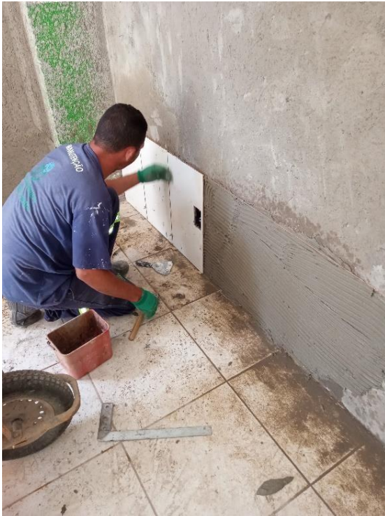
Assentamento de revestimento cerâmico (ambiente 02 do novo repouso)
