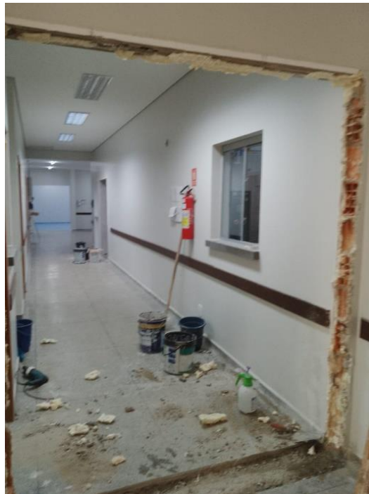
Centro Cirúrgico: reparo e pintura da porta de acesso do setor
