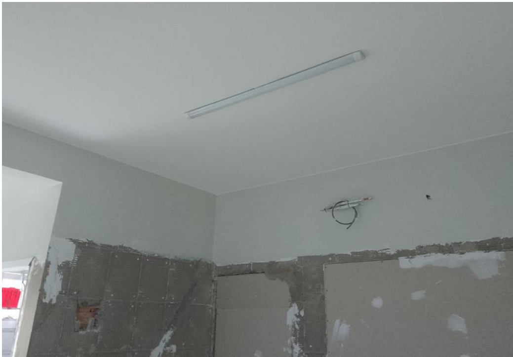
Pintura e assentamento de revestimento cerâmico (ambiente 01 do novo repouso)
