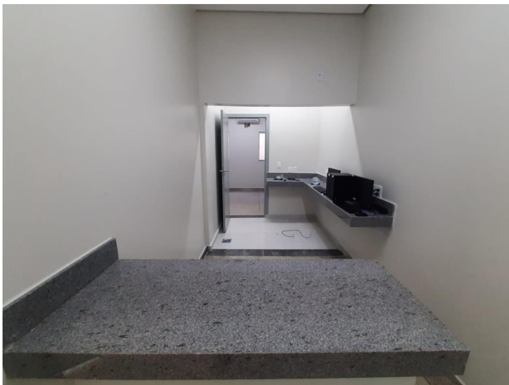
Clínica Cirúrgica: adequação de estrutura física para instalação de novo posto de enfermagem (conforme orientações da SUVISA)
