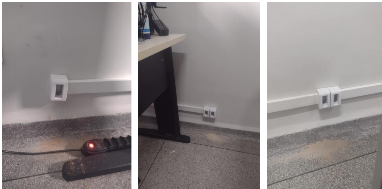
Administrativo: instalação de pontos de rede na sala do rh
