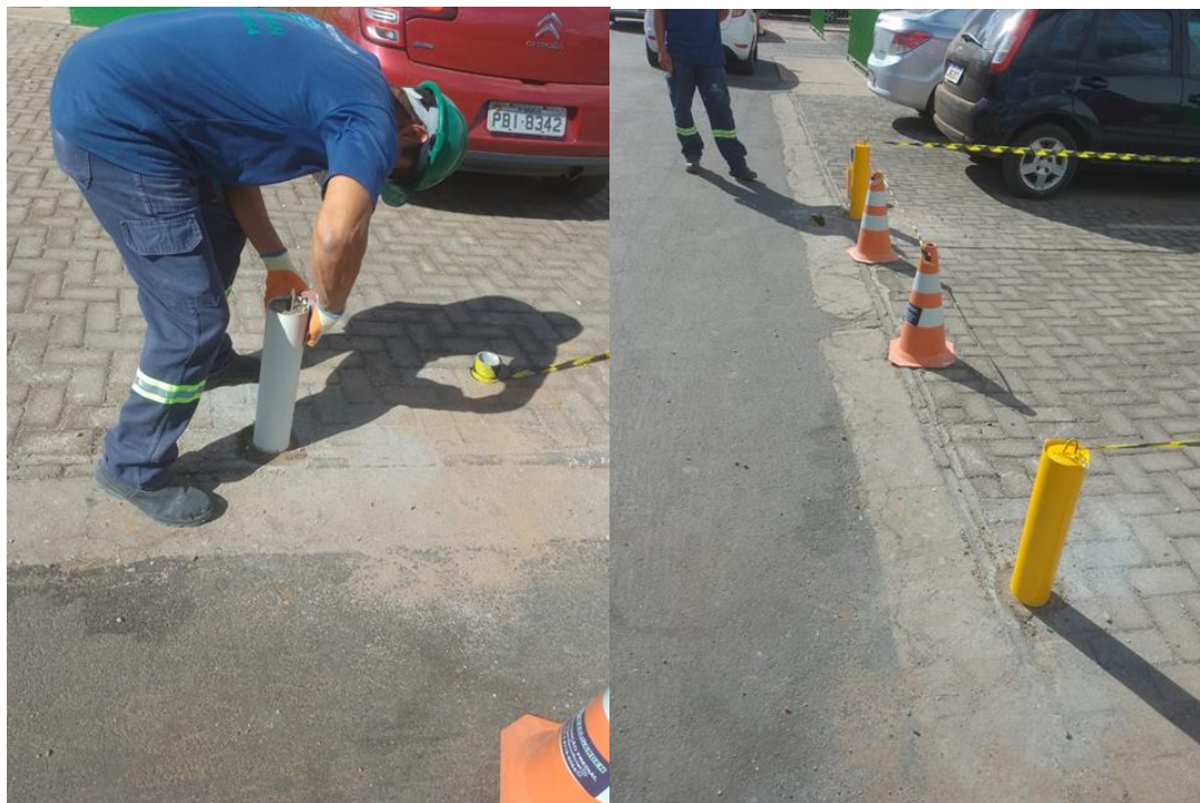
Bloqueio de vagas na área externa de descarga do refeitório
