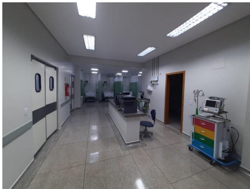
Centro Cirúrgico após adequações
