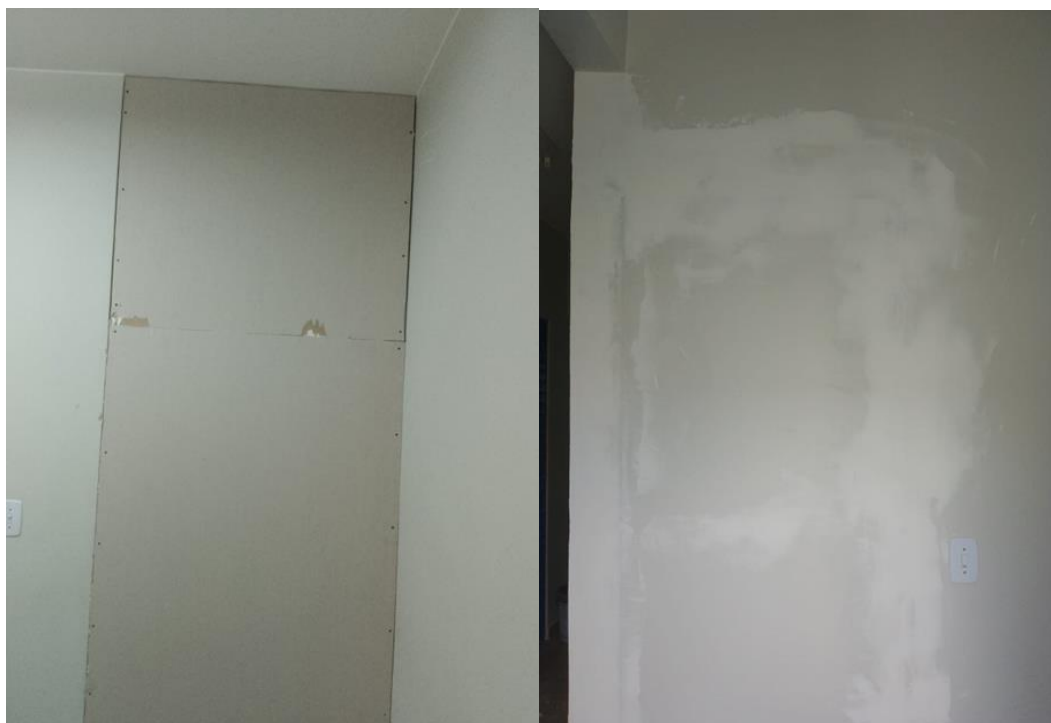
Fechamento de vão em drywall no almoxarifado da farmácia
