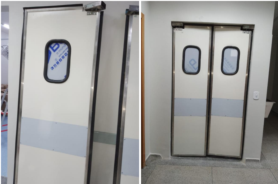
Centro Cirúrgico: instalação de novas portas nas salas cirúrgicas
