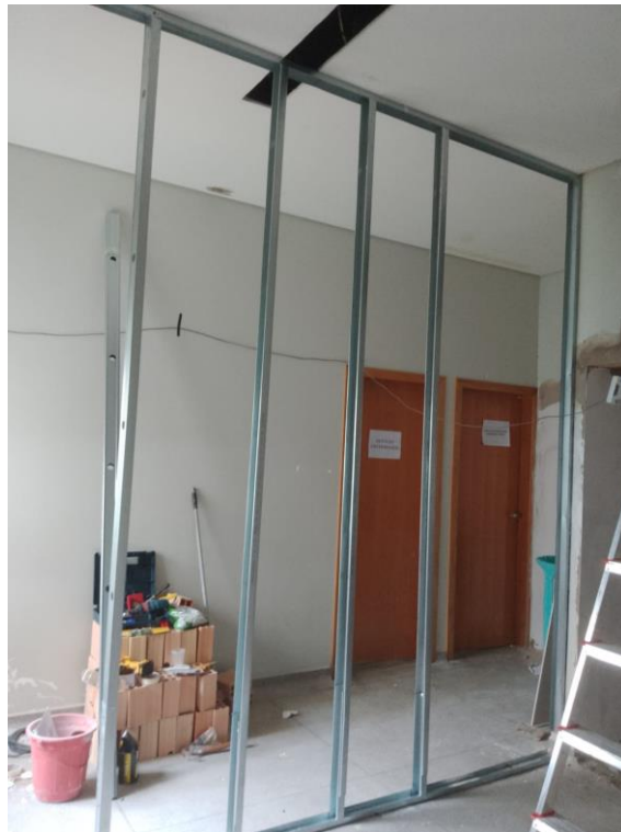
Clínica Cirúrgica: adequação de estrutura física para instalação de novo posto de enfermagem (conforme orientações da SUVISA)
