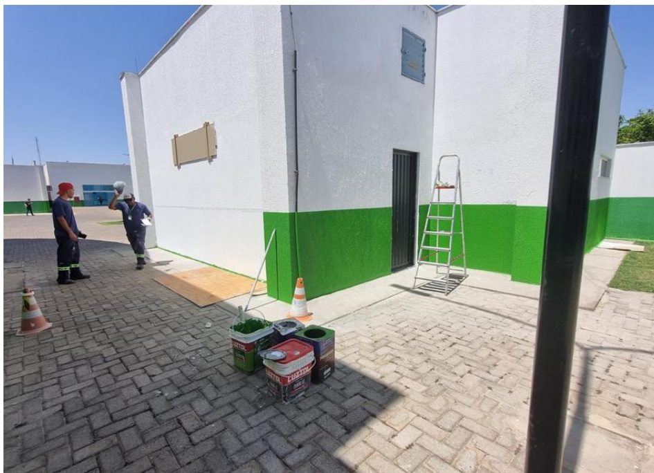
Pintura da fachada do novo repouso
