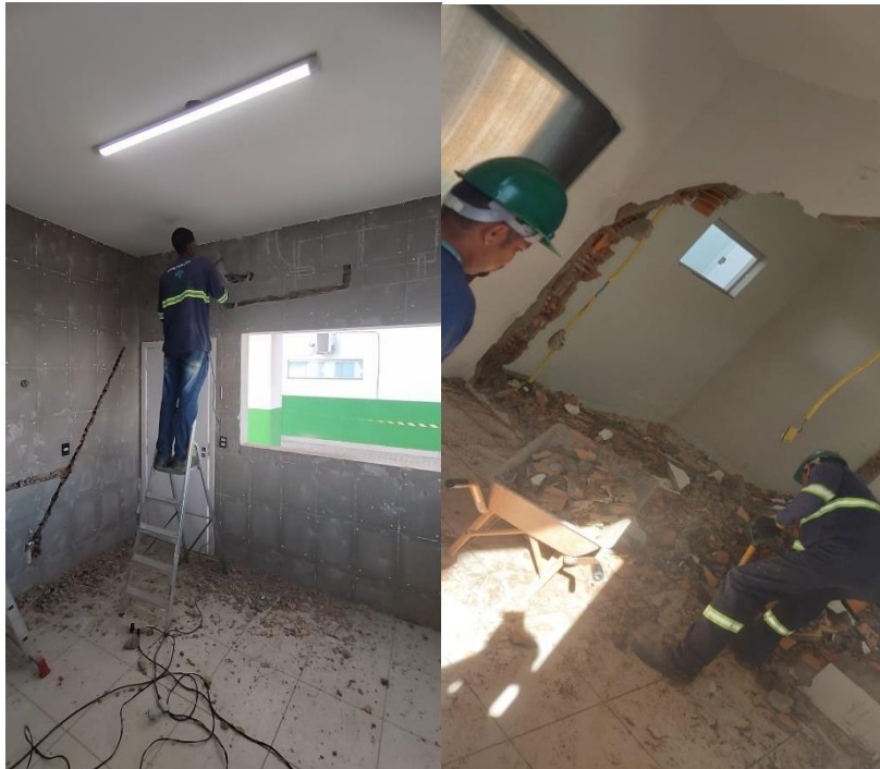
Área Externa: adequação de ambiente externo para instalação de novo repouso
