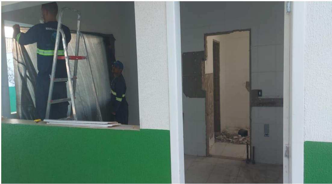
Área Externa: adequação de ambiente externo para instalação de novo repouso
