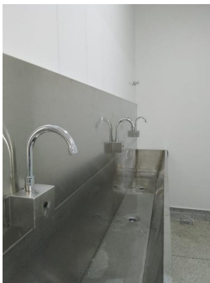
Centro Cirúrgico: instalação de torneiras automáticas
