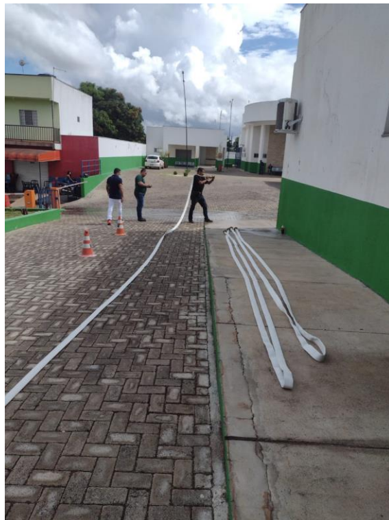
Área Comum: adequação do sistema de prevenção e combate a incêndio
