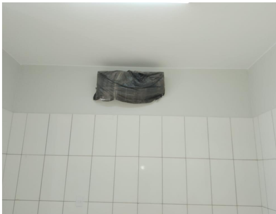
Pintura e assentamento de revestimento cerâmico (ambiente 01 do novo repouso)
