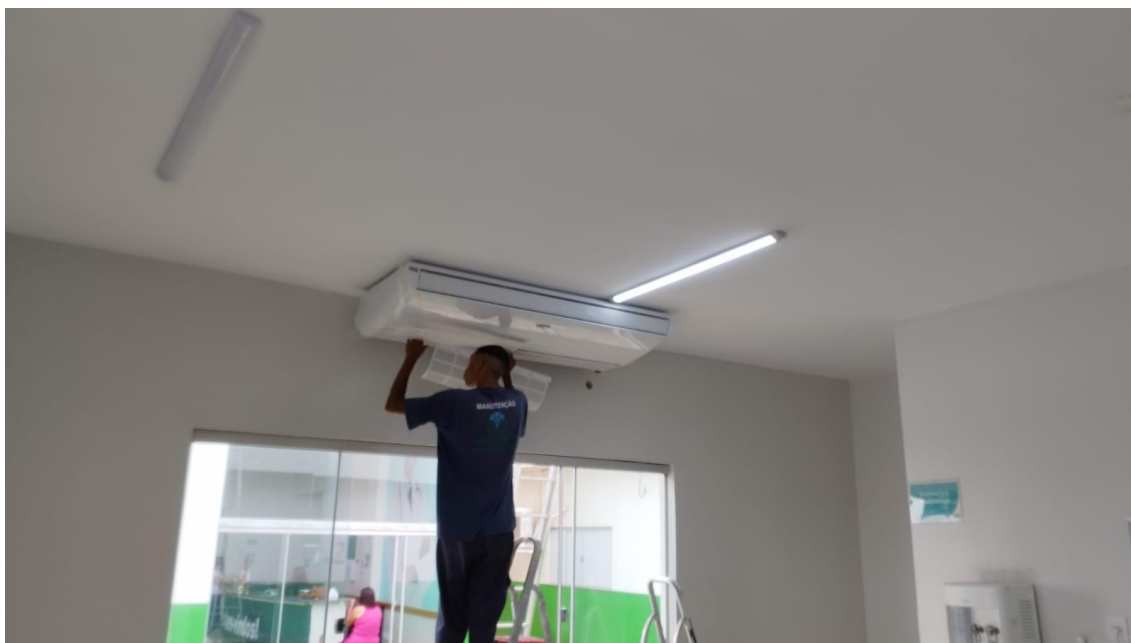
Instalação de ar condicionado na recepção do pronto socorro e enfermarias
