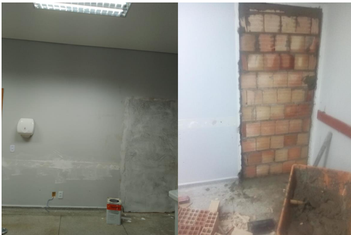
Clínica Médica: fechamento de vão de porta para adaptação da sala de utilidades (conforme orientações da SUVISA)
