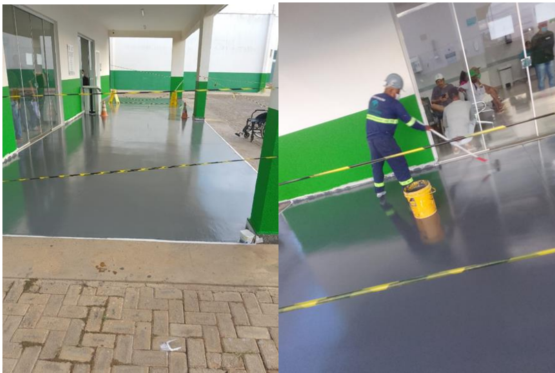
Pintura do piso e paredes do pronto socorro
