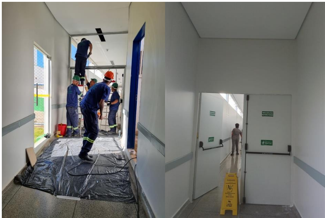
Fechamento de vão em drywall acima da porta corta fogo
