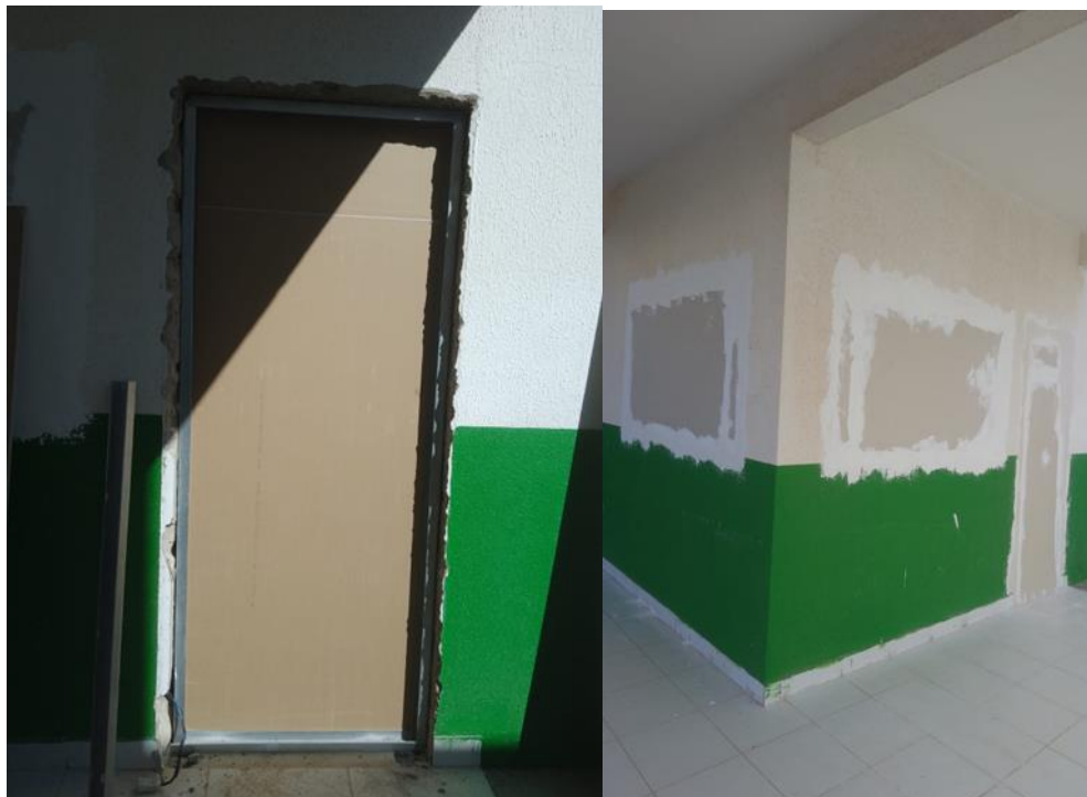
Fechamento dos vãos em drywall do ambiente 01 do novo repouso
