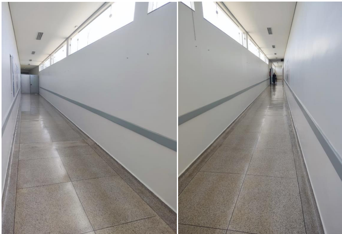
Área Comum: pintura de bate maca dos corredores principais
