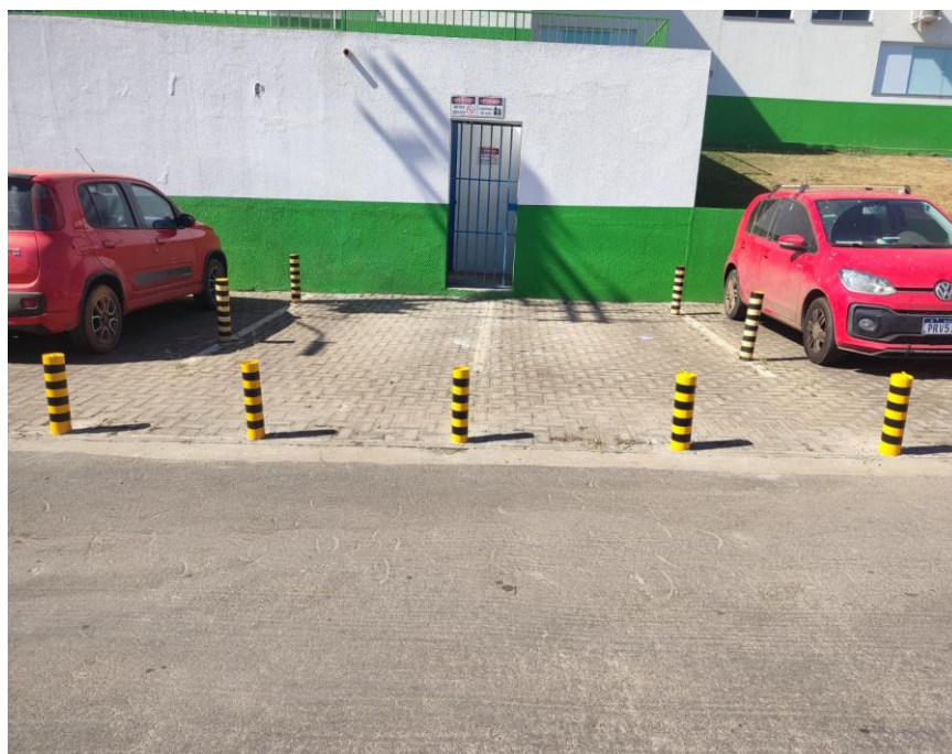
Estacionamento Externo: bloqueio de vagas em frente ao abrigo GLP
