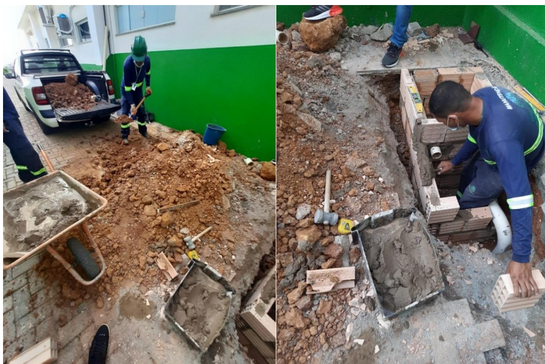
Pronto Atendimento: execução de caixa de decantação para sala de gesso
