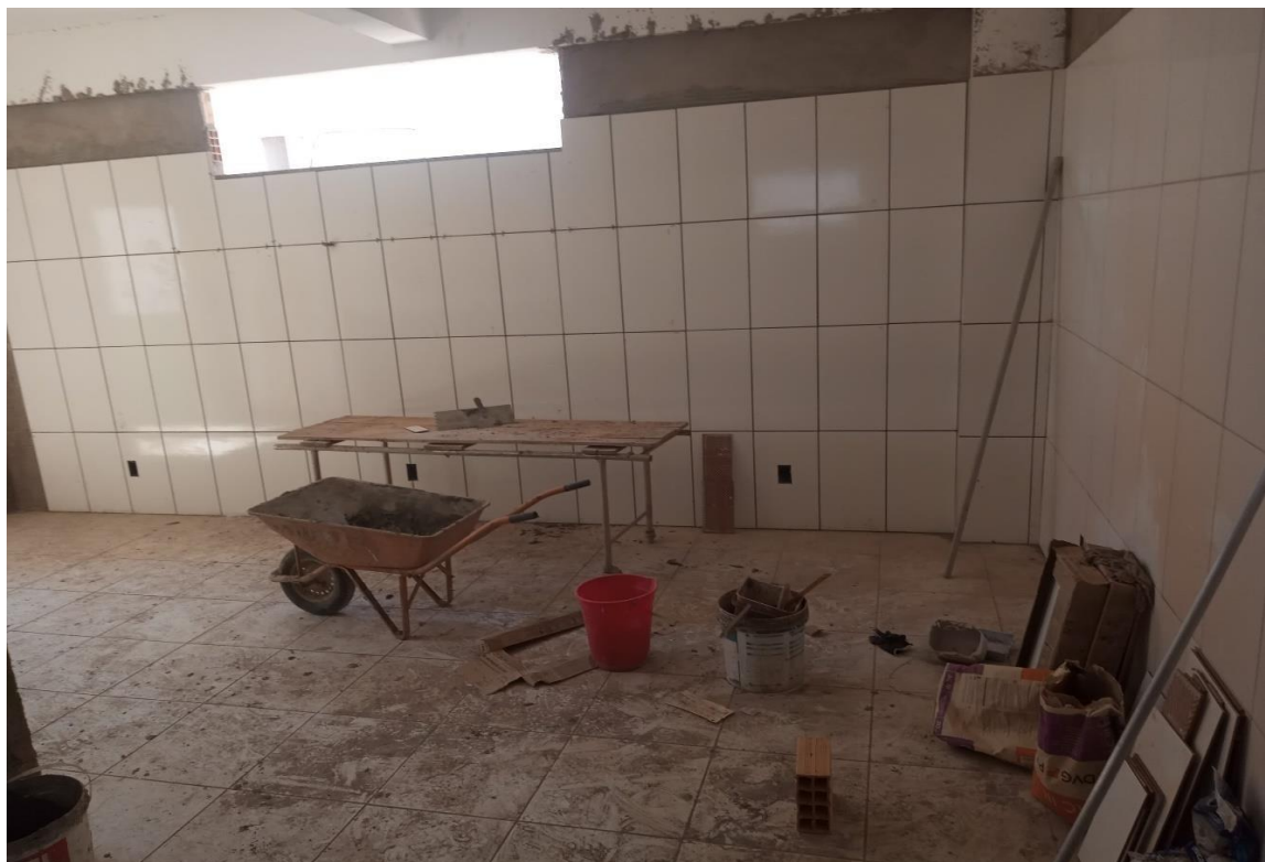
Assentamento de revestimento cerâmico (ambiente 02 do novo repouso)
