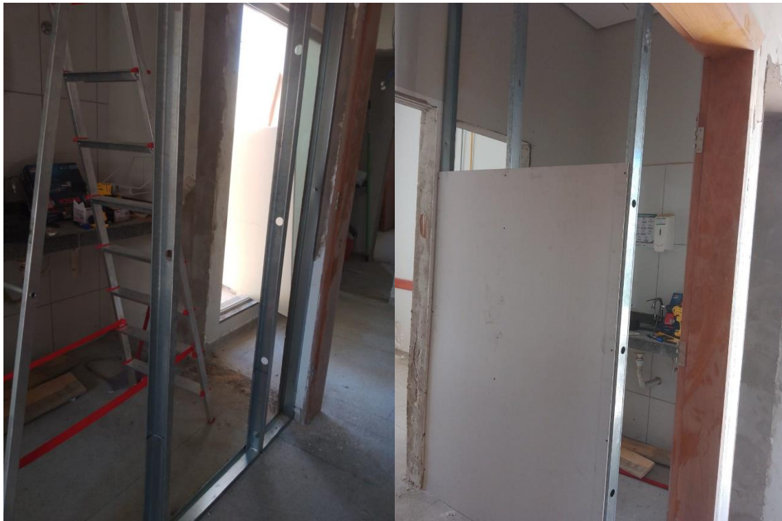
Clínica Médica: adequação dos leitos de isolamentos (conforme orientações da SUVISA)
