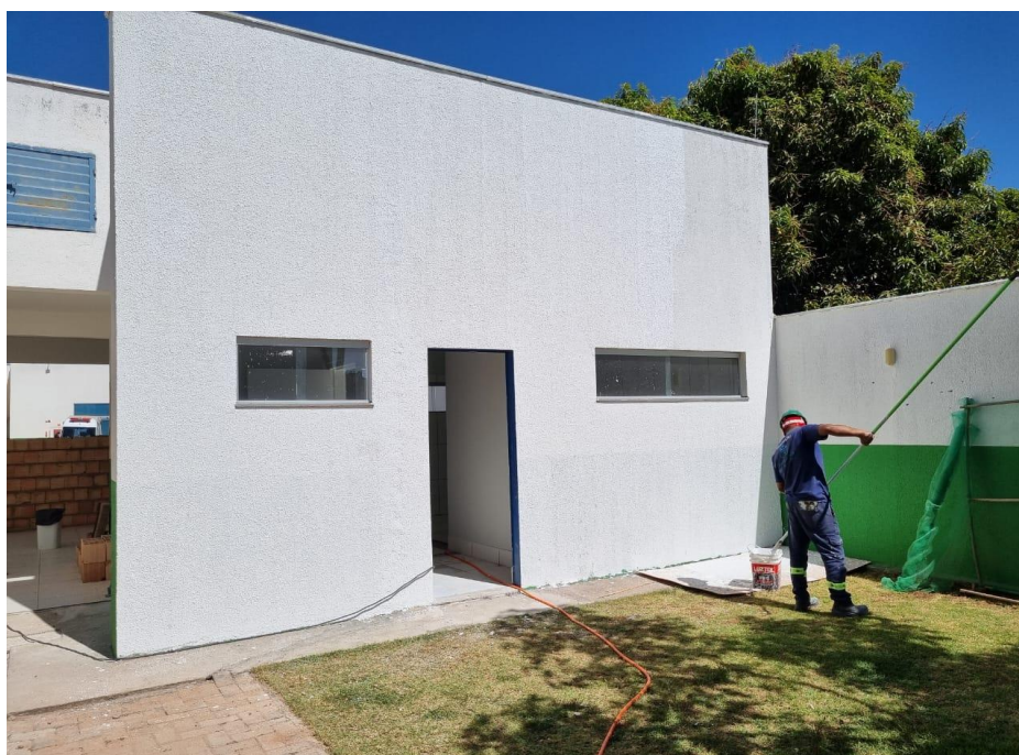
Pintura da fachada do novo ambiente de repouso
