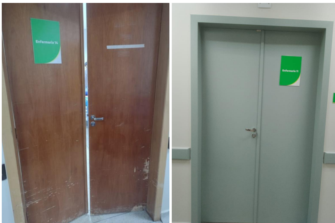
Alojamento Conjunto e Clínica Cirúrgica: recuperação de todas as portas de madeira
