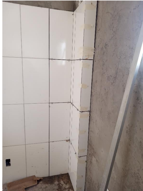
Assentamento de revestimento cerâmico (ambiente 02 do novo repouso)
