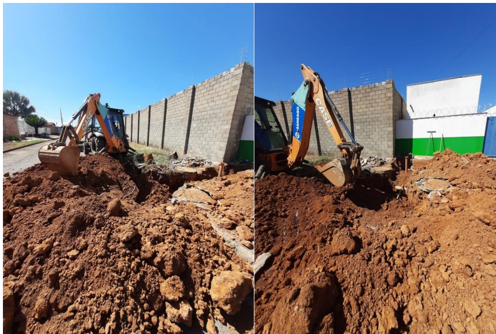
Área Externa: execução de nova infraestrutura hidráulica para abastecimento dos reservatórios de água
