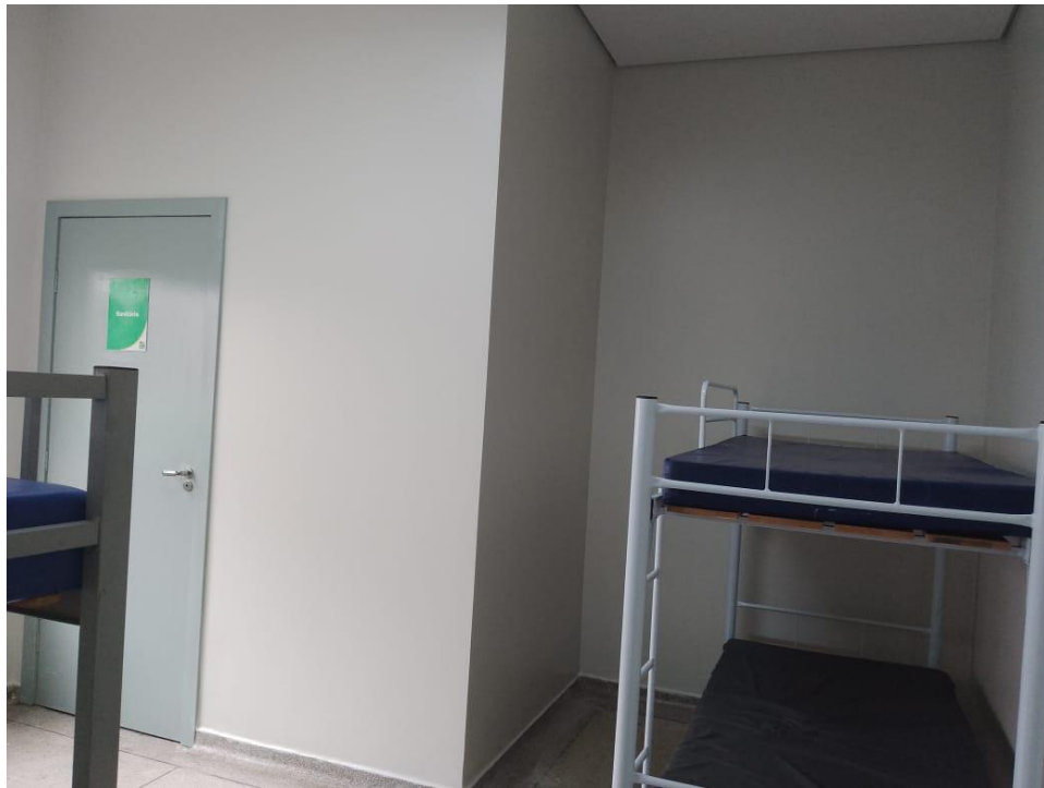
Clínica Cirúrgica: tratamento de infiltrações e revitalização de pintura dos repousos
