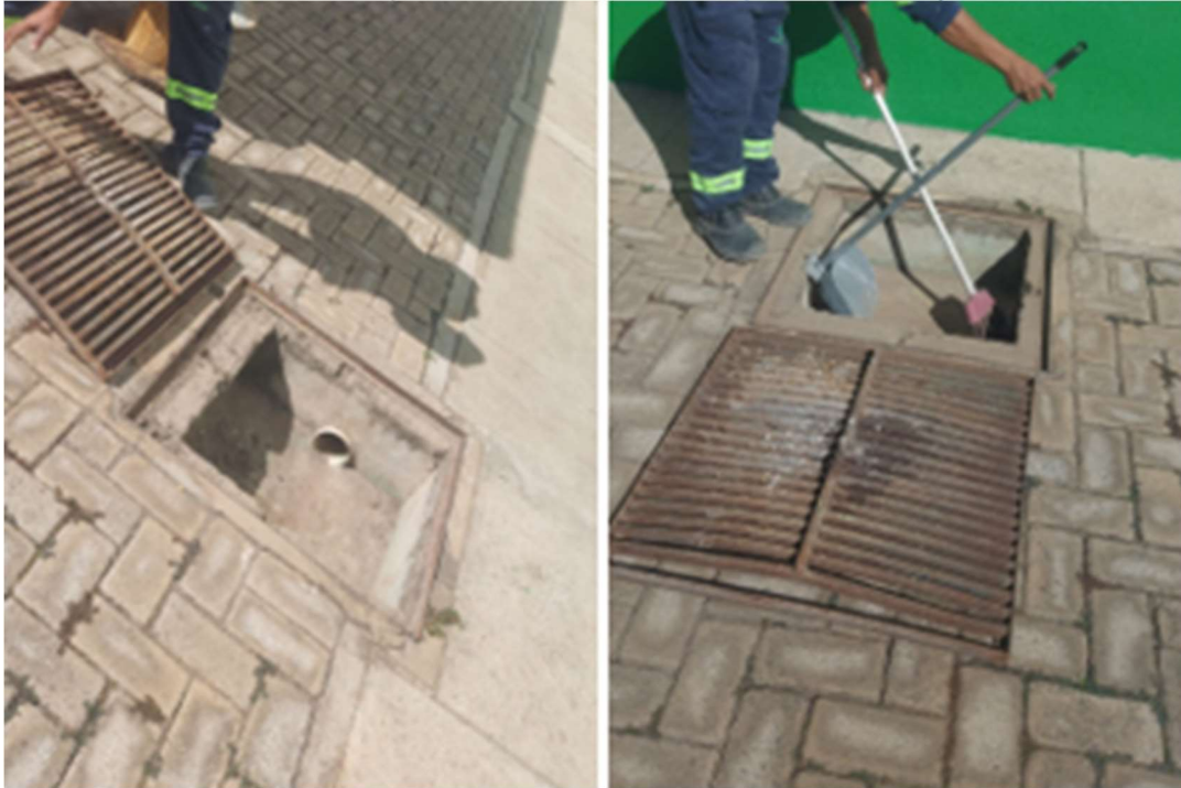
LIMPEZA DE CAIXAS DE PASSAGEM
