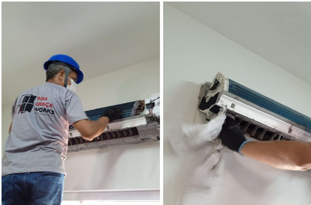
MANUTENÇÃO DE EQUIPAMENTOS DE AR CONDICIONADO
