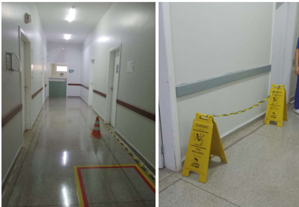
PINTURA DE CORREDOR DO SADT
