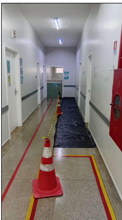
Serviço de revitalização de pintura interna em todos os setores da unidade hospitalar
