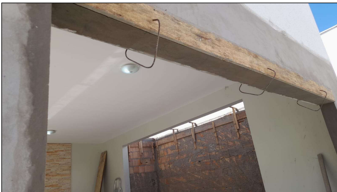
Adequação de ambiente externo para implantação de sala de descompressão
