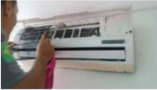
Higienização de Evaporadoras
