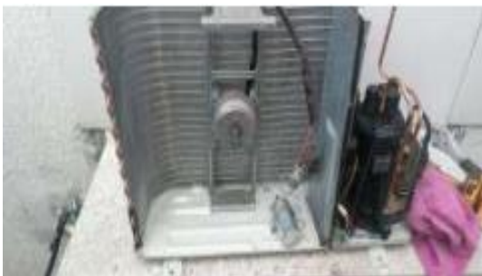
Higienização de condensadora
