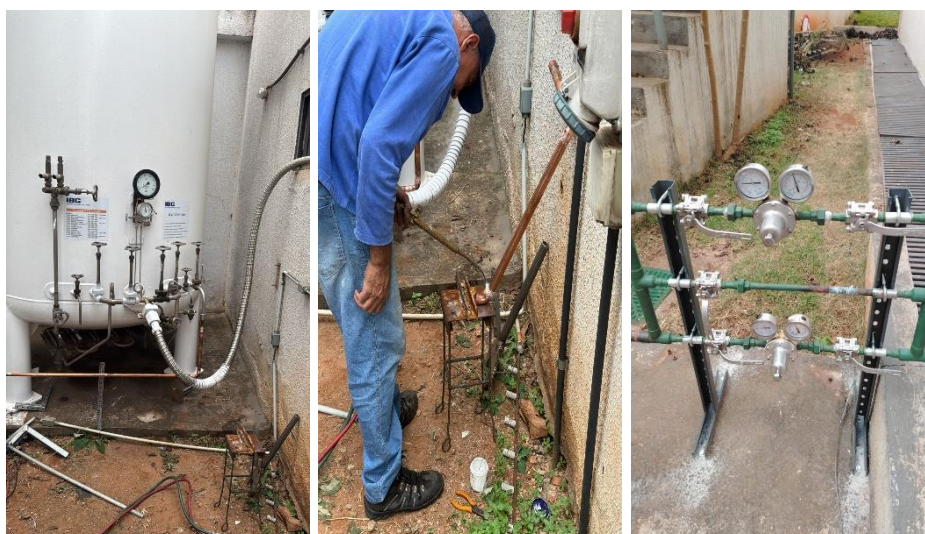
Abastecimento do tanque, montagem de tubulações e liberação da rede de oxigênio
