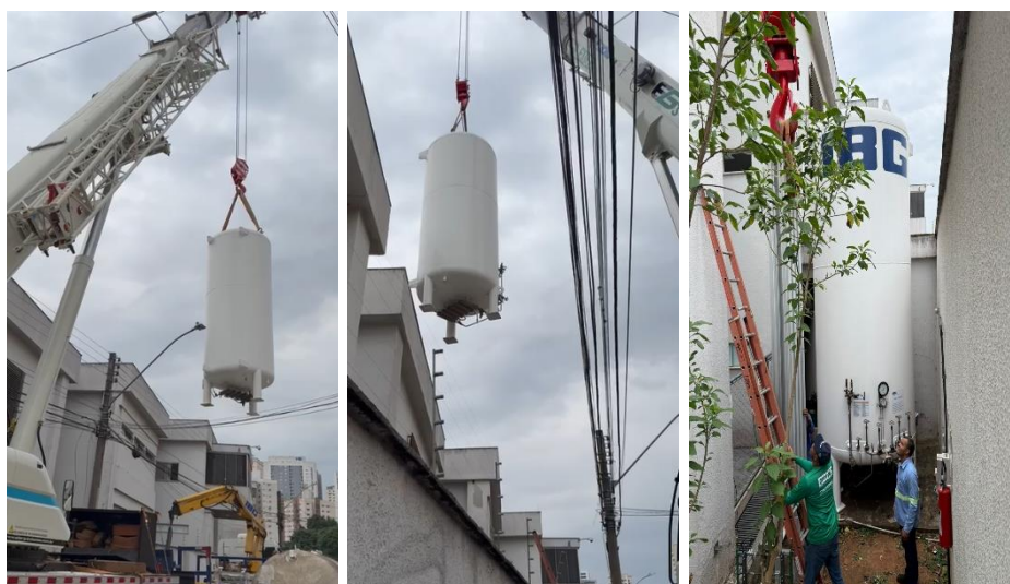
Içamento do novo tanque de oxigênio e central de vaporização
