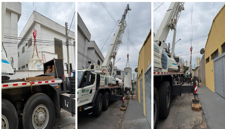
Remoção através de içamento do tanque de oxigênio e central de vaporização
