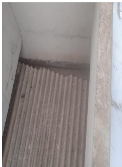
Instalação das telhas termoacústicas
