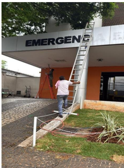
Reparo em forro de gesso e pintura da fachada da Emergência
