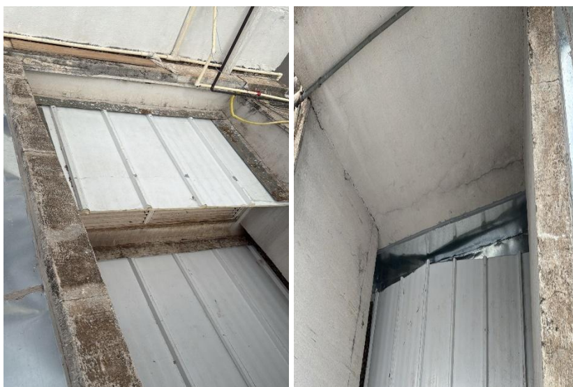
Instalação de telhas termoacústicas e Calha com maior capacidade
