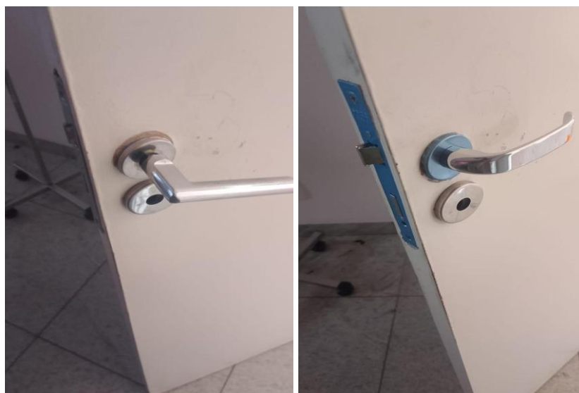
Troca de fechaduras
