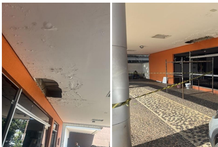
Situação em que se encontrava Entrada da Recepção da Emergência
