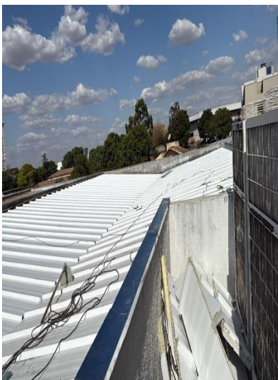
Instalação das telhas termoacústicas
