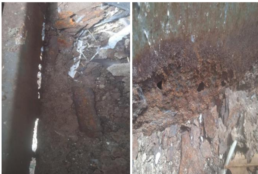
Remoção de telha em fibrocimento e Calha
