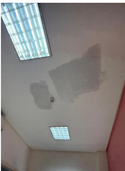
Reparo em forro de gesso e pintura da fachada da Emergência
