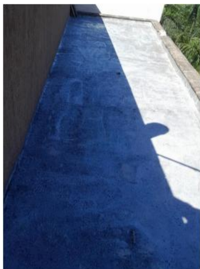
Impermeabilização de Laje e Calha
