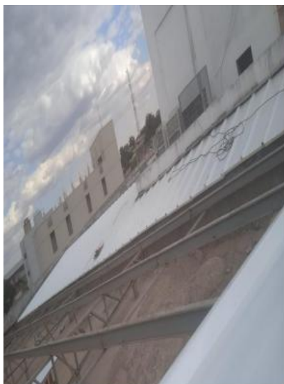
Instalação das telhas termoacústicas
