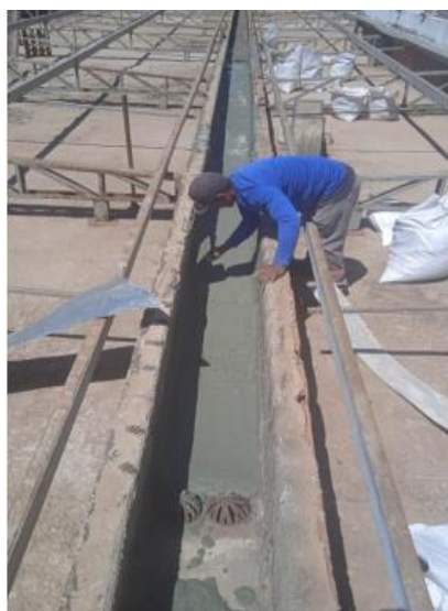
Recuperação de Calha de concreto
