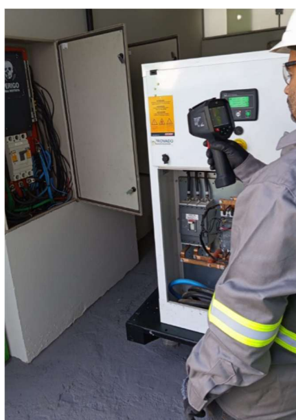
Termografia em quadros de distribuição internos
