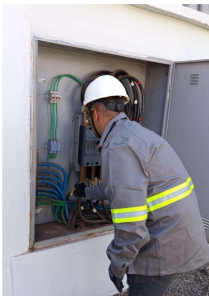
Limpeza do QDG da subestação
