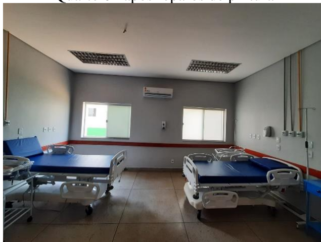
Quarto 04 após reparos de pintura
