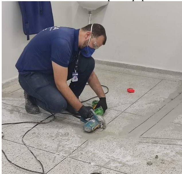
Execução de nova infraestrutura elétrica para equipamento de Raio-x fixo
