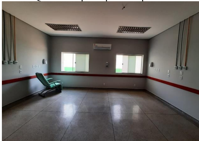
Quarto 03 após reparos de pintura
