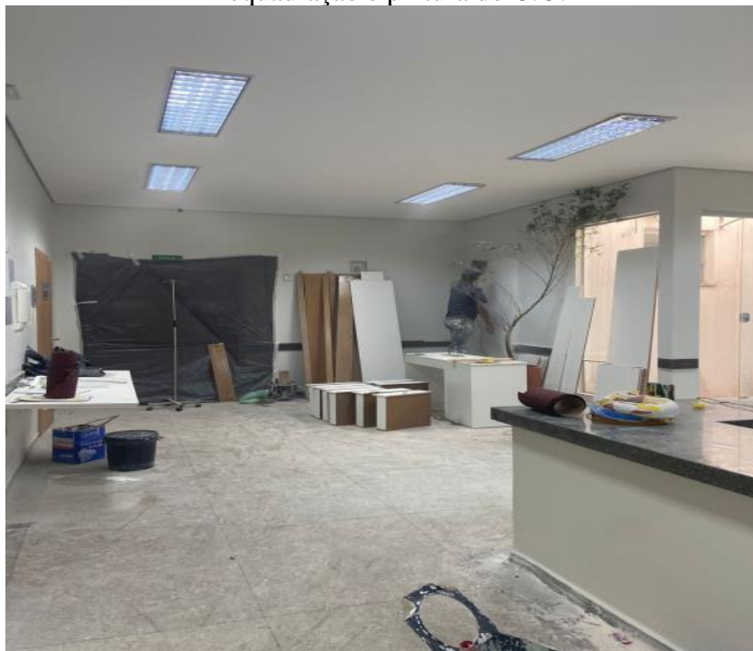
Requadração e pintura do C.O.
