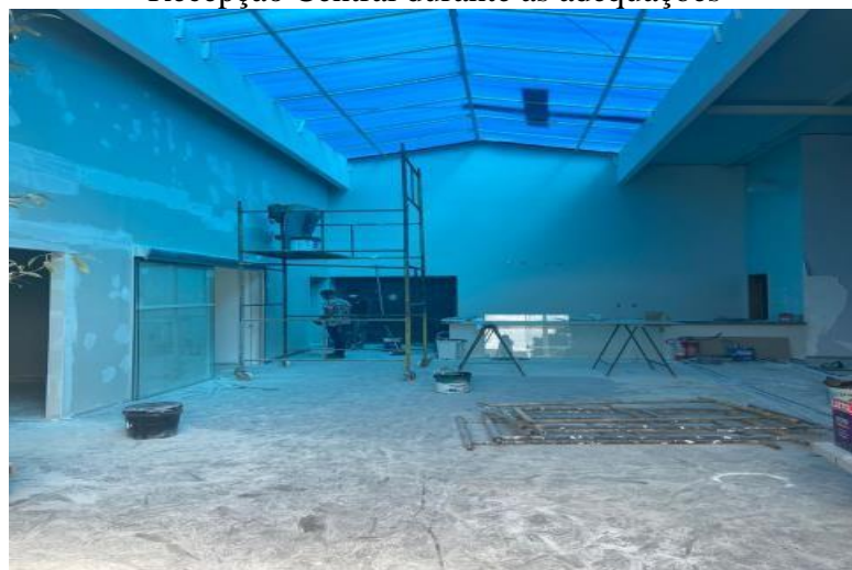
Recepção Central durante as adequações
